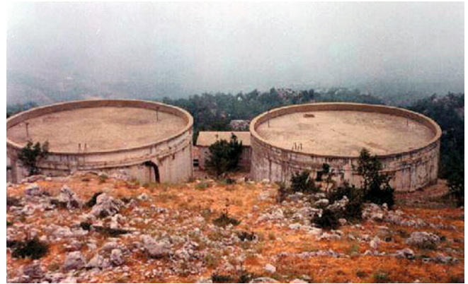
Рис. 2. Внешний вид запасных резервуаров
