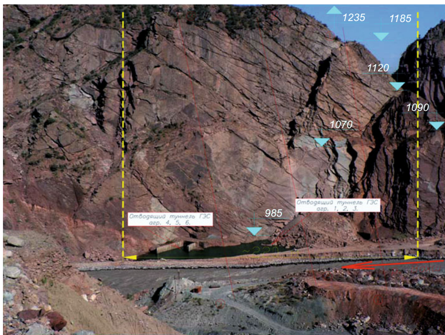
Рис. 1. Общий вид склона с границами рассматриваемого участка и расчетными сечениями
