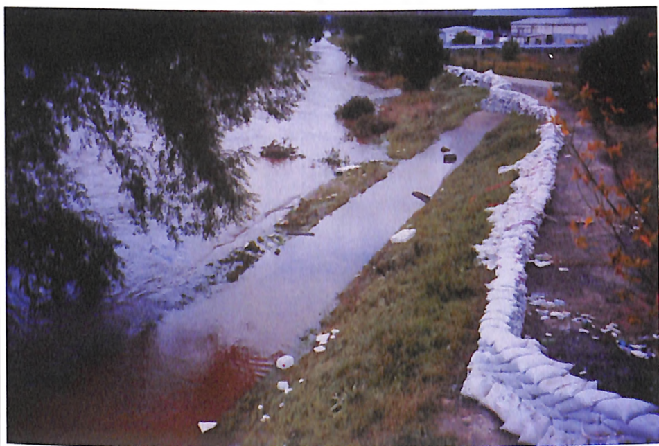
Защита территории укладкой мешков с песком (вид после спада паводка).
