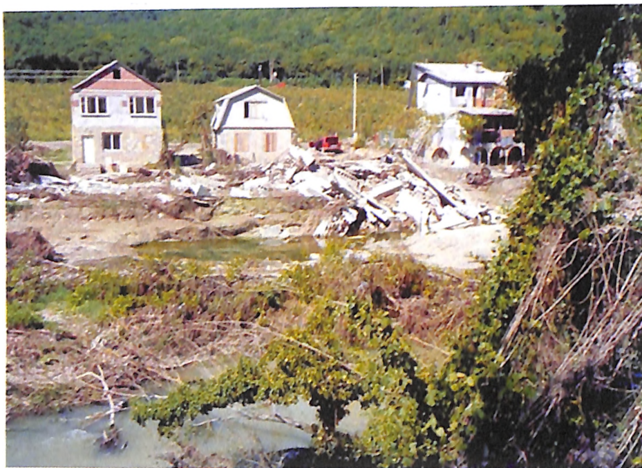
Разрушенные дома в селении Дюрсо (на переднем плане) после прохождения паводка (1,3 км от устья).
