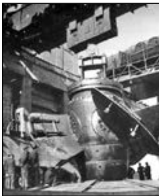
Монтаж рабочего колеса турбины Рыбинской ГЭС
