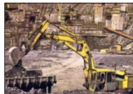
Строительство Курпсайская ГЭС
