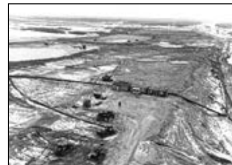
Начальный этап строительства Чебоксарской ГЭС
