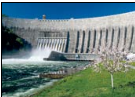
Работа водосброса Саяно-Шушенской ГЭС
