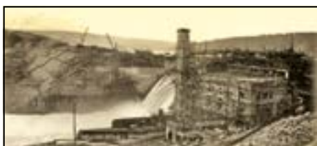
Строительство Широковской ГЭС
