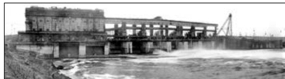
Панорама строящейся Угличской ГЭС
