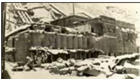
Разрушенная Баксанская ГЭС
