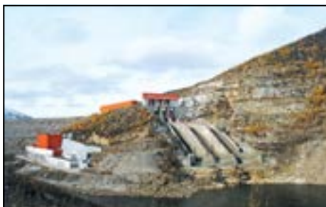
Водосбросное сооружение Колымской ГЭС
