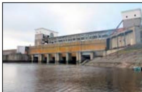
Водосбросная плотина Рыбинской ГЭС
