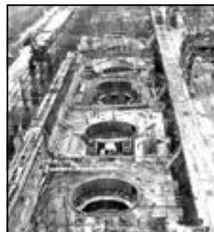
Стройплощадка Сталинградской ГЭС
