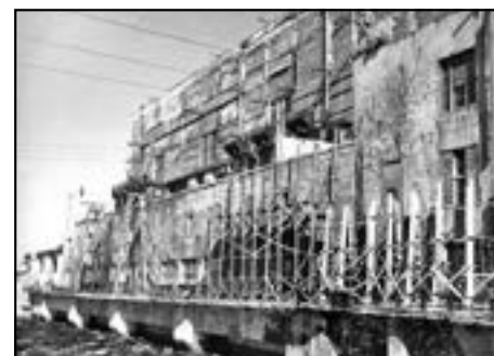
Восстановление Нижне-Свирской ГЭС
