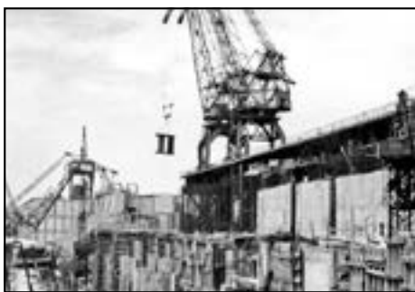
Строительство Воткинской ГЭС
