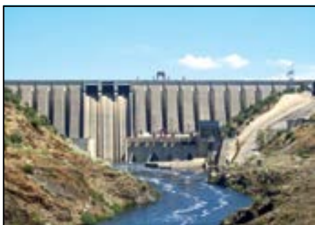
Массивно-контрфорсная плотина Алькатара (Испания)
