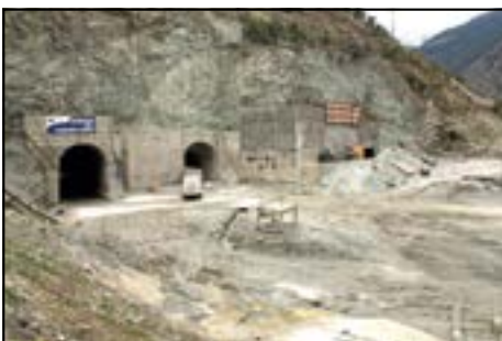
Площадка здания Зарамагской ГЭС-1
