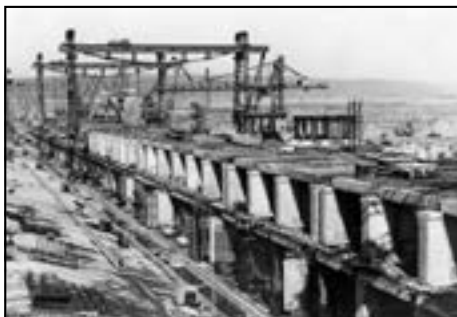
Строительство Саратовской ГЭС
