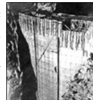
Строительство плотины Гергебильской ГЭС
