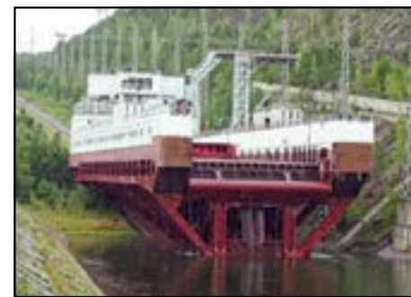
Судоподъемник Красноярской ГЭС
