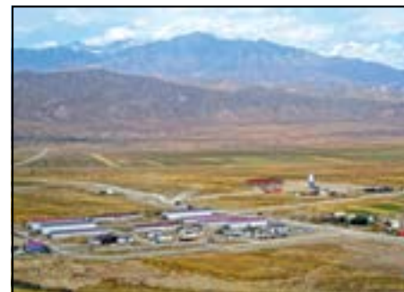
Поселок строителей Верхне-Нарынского каскада
