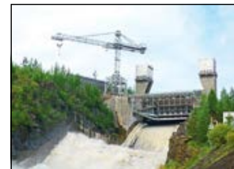
Водосброс Вилюйской ГЭС
