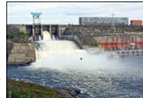
Курейская ГЭС. Фото ОАО «НТЭК»
