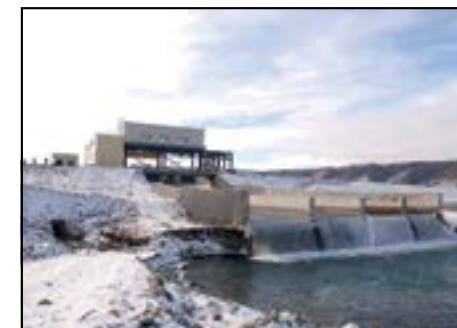
Водозаборный узел на Большом Зеленчуке
