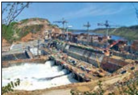
Строительство Бурейской ГЭС
