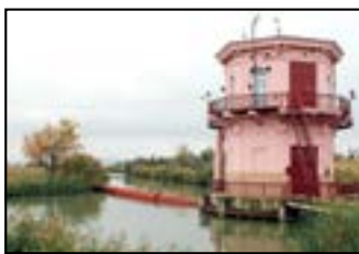
Водозаборное сооружение Сенгилеевской ГЭС
