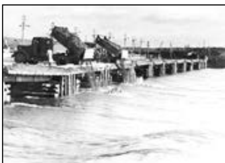
Перекрытие Камы на строительстве Камской ГЭС
