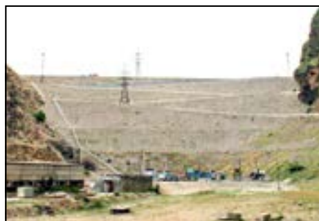
Плотина Ирганайской ГЭС
