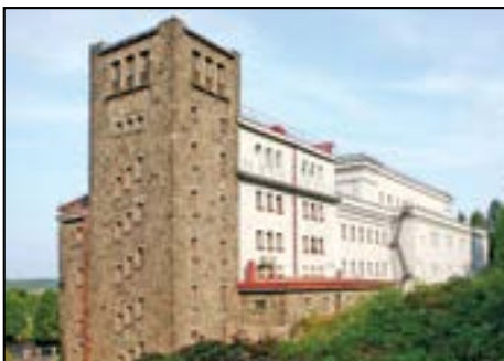
Кондопожская ГЭС Фото ТГК-1
