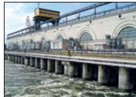
Здание Нижегородской ГЭС
