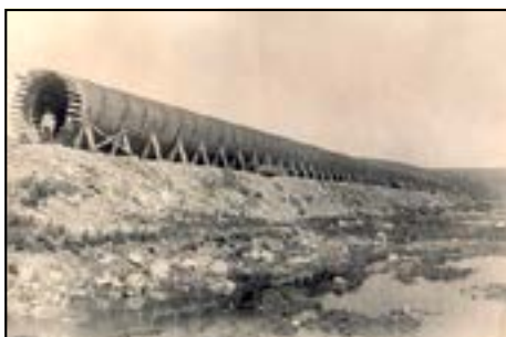
Строительство водовода Ульбинской ГЭС
