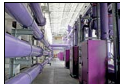
КРУЭ-500 кВ Бурейской ГЭС
