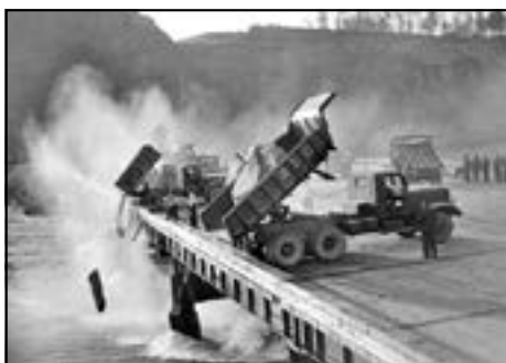
Перекрытие Ангары на строительстве Братской ГЭС
