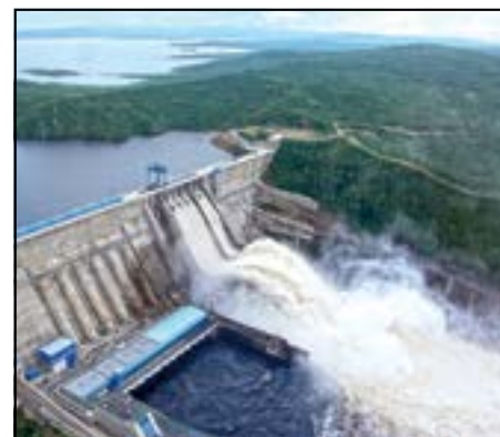
Гравитационная плотина Бурейской ГЭС
