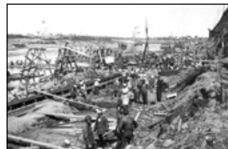
Земляные работы на строительстве Угличской ГЭС
