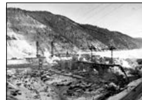
Возведение водосбросной плотины Красноярской ГЭС
