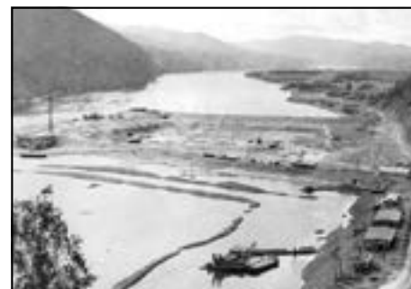
Начальный этап строительства Красноярской ГЭС — сооружение котлована
