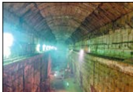
Подземная выработка машинного зала Рогунской ГЭС
