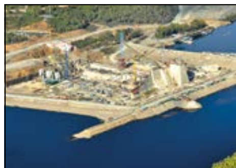
Строительство Нижне-Бурейской ГЭС в 2014 году
