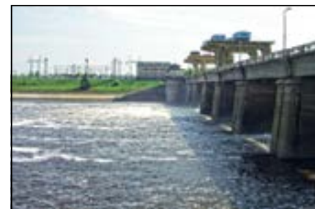
Водосбросная плотина Ивановской ГЭС
