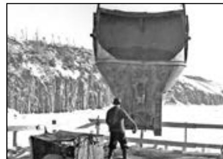
Укладка бетона на строительстве Братской ГЭС
