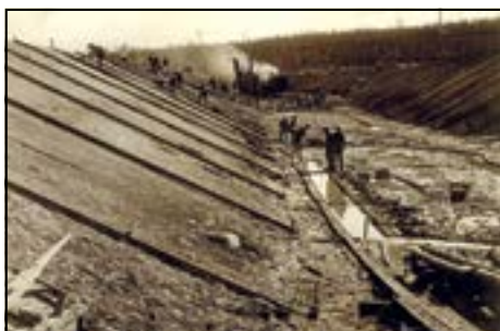
Строительство деривационного канала Нива ГЭС-2
