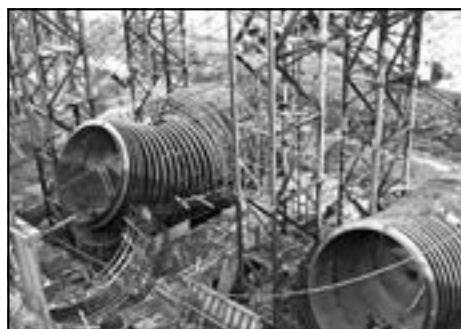
Монтаж водоводов Братской ГЭС
