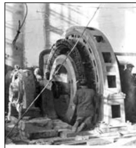
Монтаж гидроагрегата Кондопожской ГЭС. Фото ТГК-1
