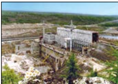
Строительство Вилюйской ГЭС-3. Фото ОАО «Вилюйская ГЭС-3»
