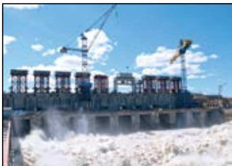
Строящаяся Усть-Среднеканская ГЭС в 2013 году
