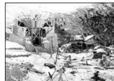
Строительство водоприемника Гизельдонской ГЭС
