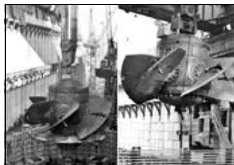
Монтаж рабочего колеса турбины Куйбышевской ГЭС
