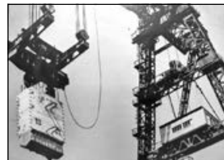
Монтаж сборного железобетона на Саратовской ГЭС
