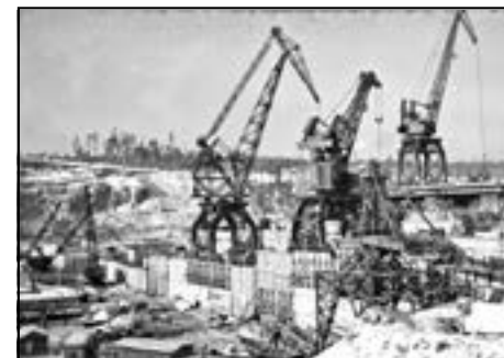
Строительство Братской ГЭС
