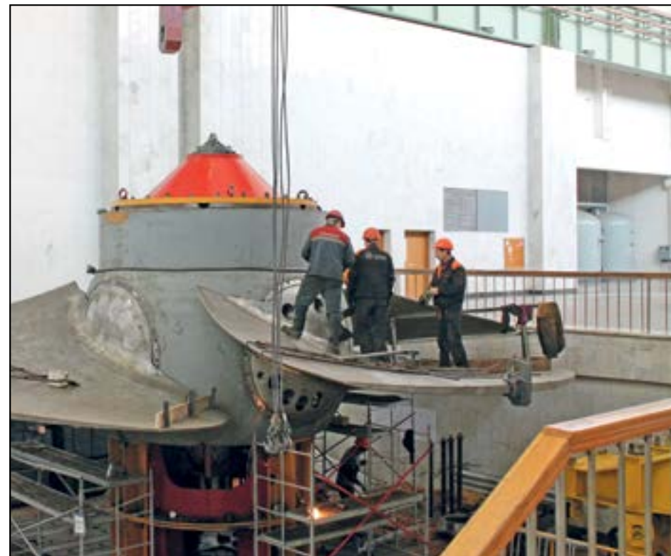
Монтаж реконструированного рабочего колеса турбины Чебоксарской ГЭС
