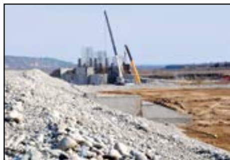
Строительство Зарагижской ГЭС
