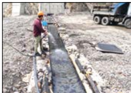
Асфальтобетонная диафрагма Гоцатлинской ГЭС
