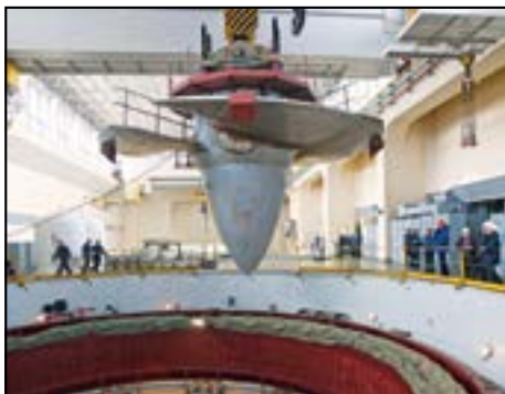
Рабочее колесо поворотно-лопастной турбины
