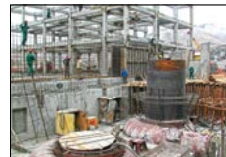
Монтаж агрегатов Гунибской ГЭС
