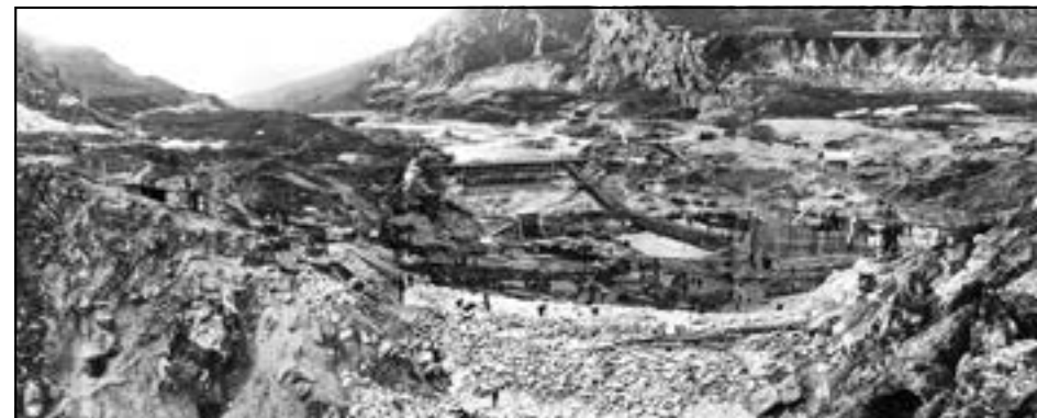
Строительство головного узла Гизельдонской ГЭС
