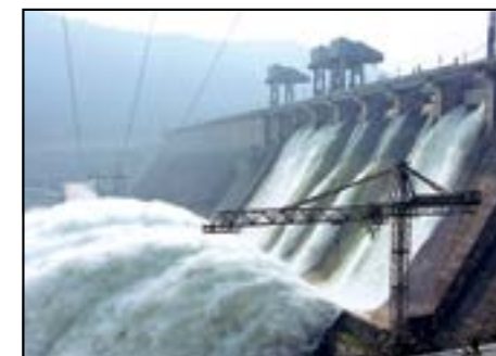
Работа водосброса Красноярской ГЭС
