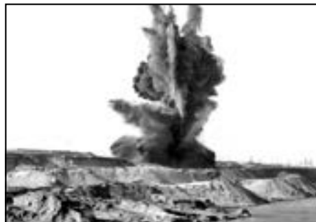
Взрыв перемычки котлована
