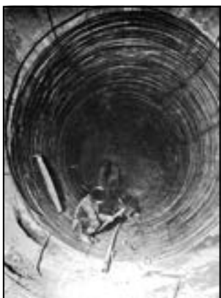
Строительство тоннеля Гизельдонской ГЭС
