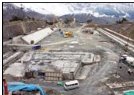
Строительство бассейна суточного регулирования Зарамагской ГЭС-1
