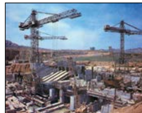
Строительство Шамалдысайской ГЭС
