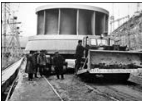
Рабочее колесо турбины Красноярской ГЭС
