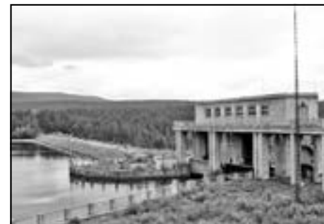
Головной узел Нива ГЭС-3
