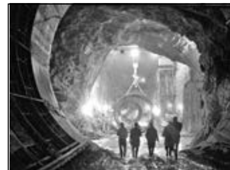
Строительство подземных сооружений Нурекской ГЭС. Фото Всеволода Тарасевича
