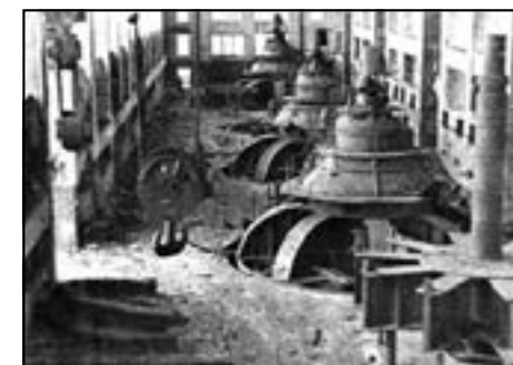
Машинный зал Нижне-Свирской ГЭС в 1944 году
