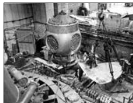
Монтаж турбины Чебоксарской ГЭС
