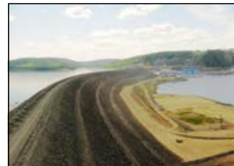
Каменно-набросная плотина Богучанской ГЭС
