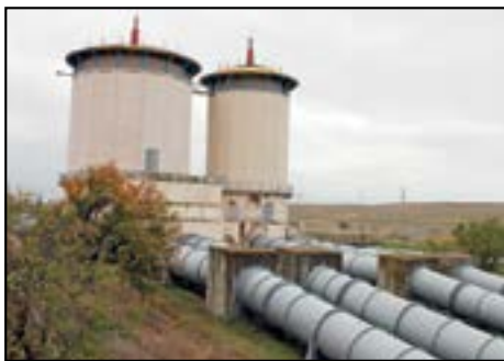
Уравнительные резервуары Свистухинской ГЭС
