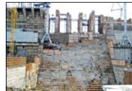
Возведение водосброса №2 Богучанской ГЭС
