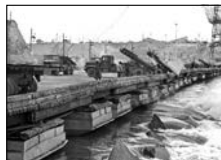
Перекрытие Волги на строительстве Куйбышевской ГЭС
