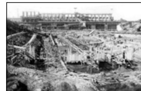
Строительство Угличской ГЭС
