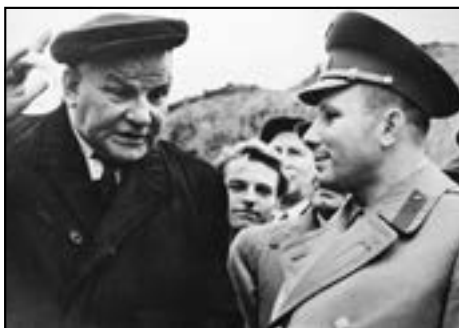
Андрей Бочкин и Юрий Гагарин на строительстве Красноярской ГЭС
