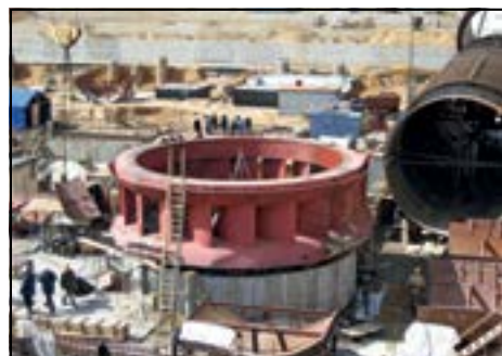
Статор турбины
