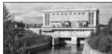
Нива ГЭС-1. Фото ТГК-1
