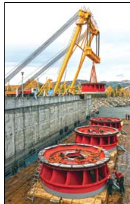
Доставка рабочих колес новых турбин Саяно-Шушенской ГЭС
