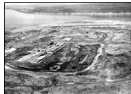
Котлован Саратовской ГЭС
