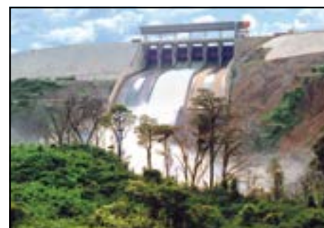
Водосброс ГЭС Яли
