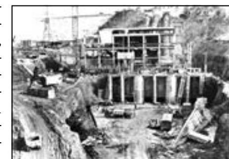
Строительство Перепадной ГЭС-1
