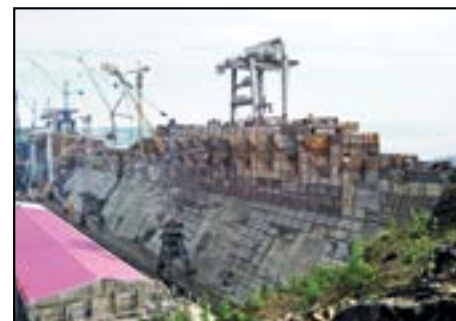
Строительство Богучанской ГЭС
