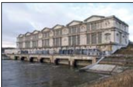
Здание Рыбинской ГЭС
