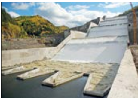
Береговой водосброс Саяно-Шушенской ГЭС
