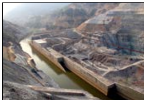
Строительство ГЭС Лай Чау
