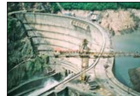
Плотина Ингурской ГЭС
