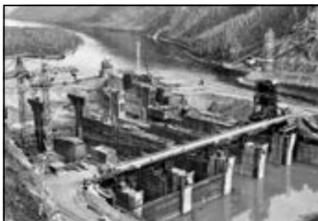
Строительство Зейской ГЭС
