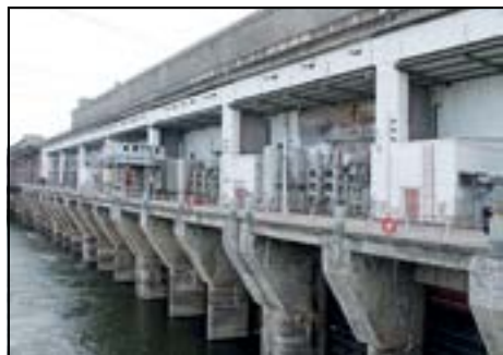
Здание Новосибирской ГЭС
