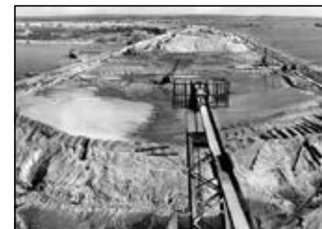
Строительство плотины Новосибирской ГЭС
