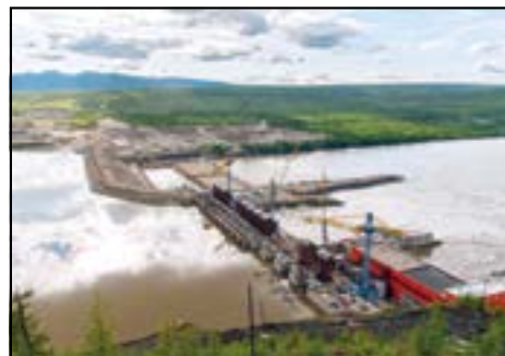
Водосбросная плотина Усть-Среднеканской ГЭС
