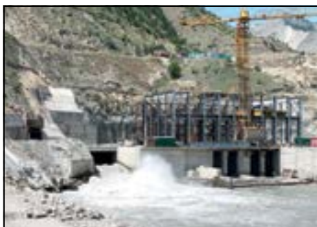
Здание строящейся Гоцатлинской ГЭС
