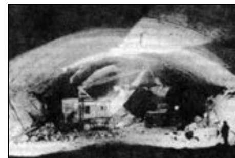
Строительство временного водосбросного сооружения Колымской ГЭС
