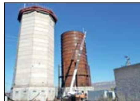
Строительство уравнительного резервуара Зеленчукской ГЭС-ГАЭС
