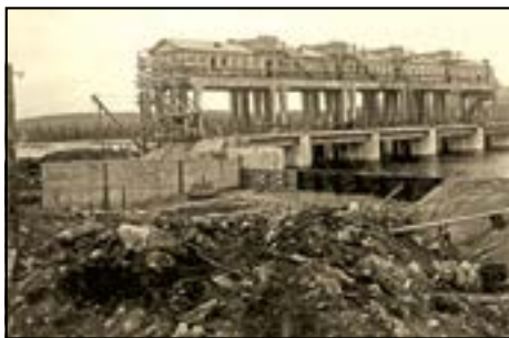
Строительство головного сооружения Нива ГЭС-2
