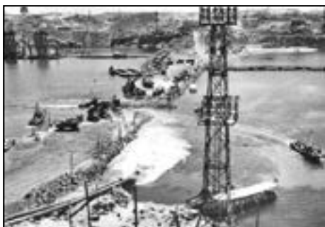
Перекрытие Нила на строительстве Асуанской ГЭС
