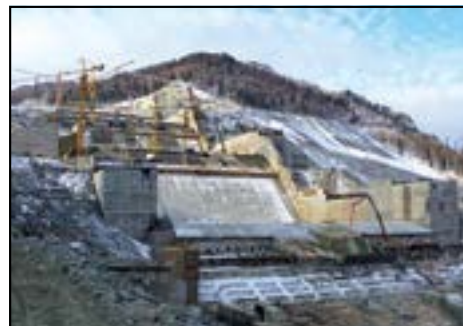
Строительство берегового водосброса
