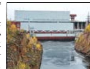
Кривопорожская ГЭС. Фото ТГК-1
