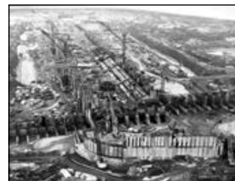
Строительство Чебоксарской ГЭС
