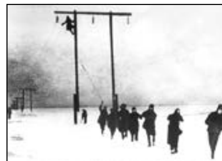
Строительство линии электропередачи от Волховской ГЭС в Ленинград по льду Ладожского озера
