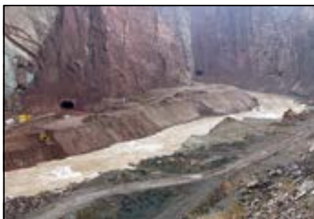
Порталы тоннелей Рогунской ГЭС
