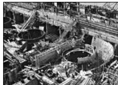
Монтаж гидроагрегатов Новосибирской ГЭС
