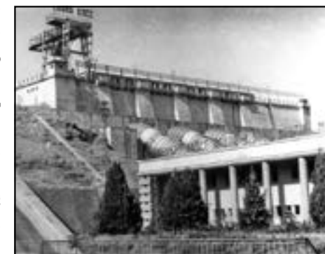
Чирчикская ГЭС. Фото Ленгидросталь
