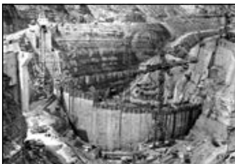
Строительство Миатлинской ГЭС
