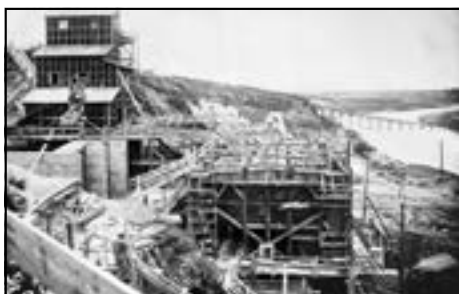
Строительство Сызранской ГЭС
