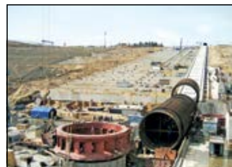
Монтаж турбин и водоводов Загорской ГАЭС-2
