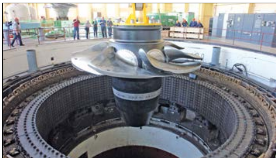
▼ Новое рабочее колесо турбины Миатлинской ГЭС
