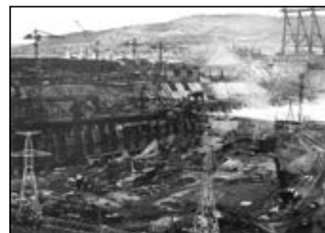
Строительство Красноярской ГЭС на завершающем этапе
