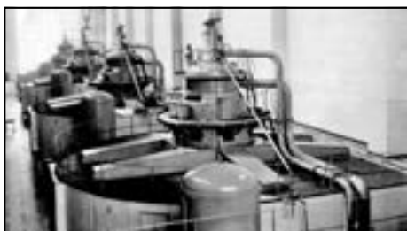
Машинный зал Лесогорской ГЭС
