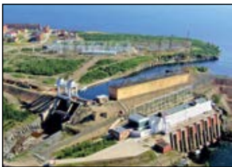
Усть-Хантайская ГЭС. Фото Гидроспецпроекта
