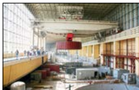
Перенос ротора нового гидрогенератора
