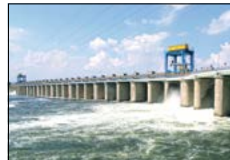
Водосбросная плотина Каховской ГЭС
