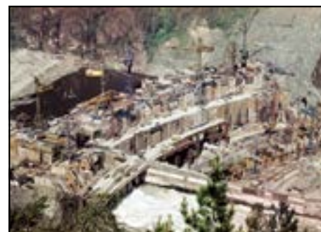
Строительство Саяно-Шушенской ГЭС
