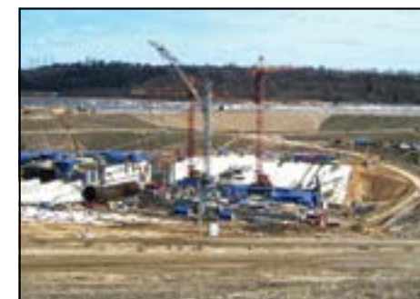
Общий вид строительства Загорской ГАЭС-2
