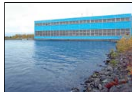
Палокорвская ГЭС. Фото ТГК-1
