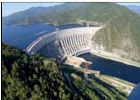
Саяно-Шушенская ГЭС — пример плотинной гидроэлектростанции
