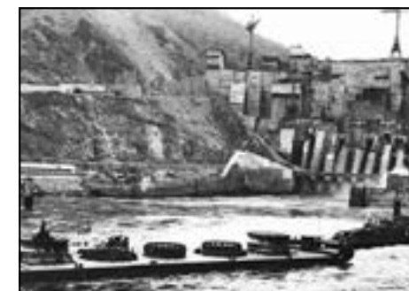
Доставка рабочих колес турбин Саяно-Шушенской ГЭС
