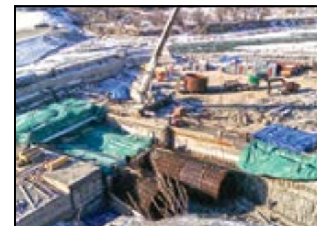
Монтаж водоводов Зеленчукской ГЭС-ГАЭС
