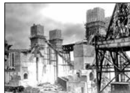
Строительство Верхне-Свирской ГЭС
