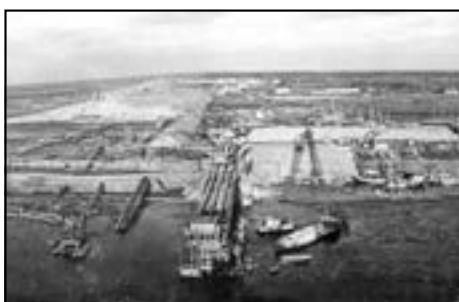
Строительство Рыбинской ГЭС
