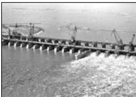
Панорама строительства Куйбышевской ГЭС
