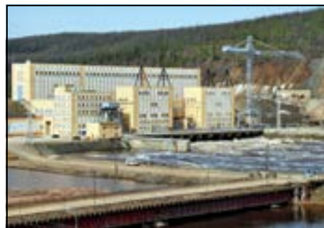
Вилюйская ГЭС-3. Фото ОАО «Вилюйская ГЭС-3»
