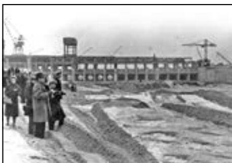
Строительство Киевской ГЭС
