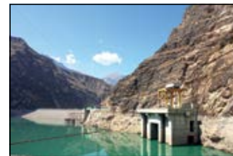
Водоприемник и плотина Ирганайской ГЭС со стороны водохранилища
