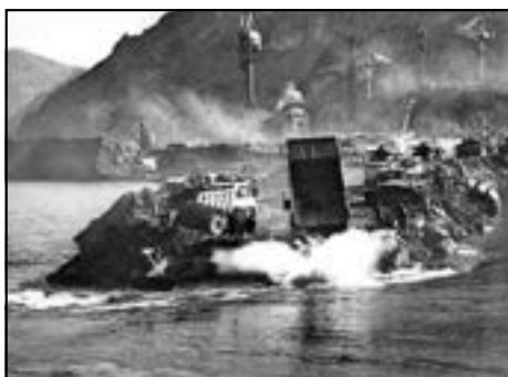
Перекрытие Енисея на строительстве Саяно-Шушенской ГЭС
