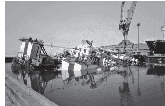
Рис. 2. Обрушение стапеля с установленным на нем буксиром [2]
