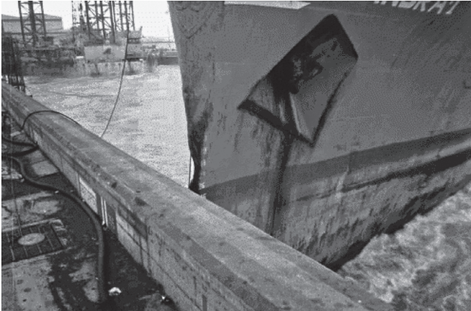
Рис. 3. Удар судна о береговую стенку [2]
