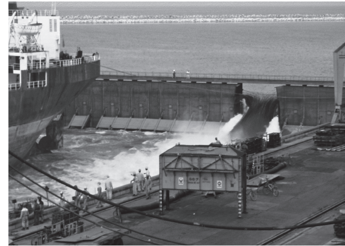
Рис. 1. Прорыв напорного фронта сухого дока в Дубаи [1]
