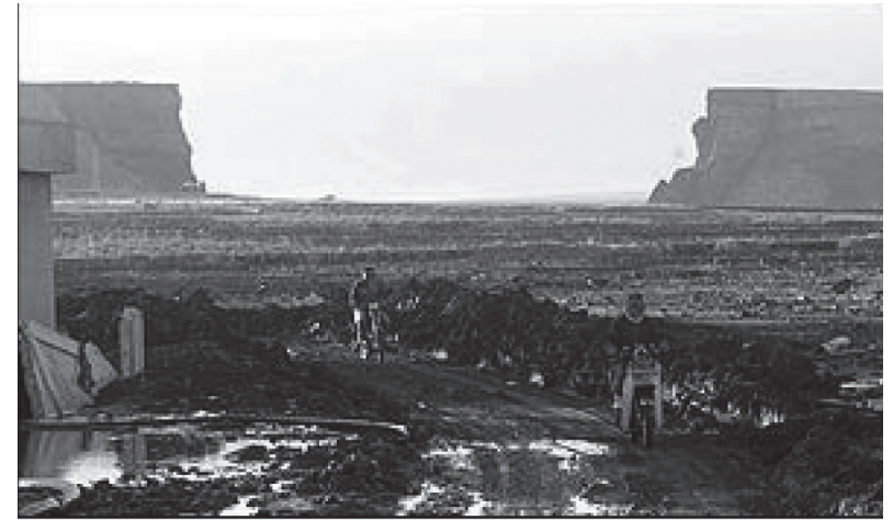
Рис. 1. Проран в плотине Zeuzoun (Сирия) после перелива воды через гребень
