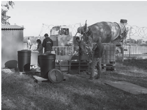
Рис. 8. Контрольный пункт для отбора проб и введения добавок в бетонную смесь
