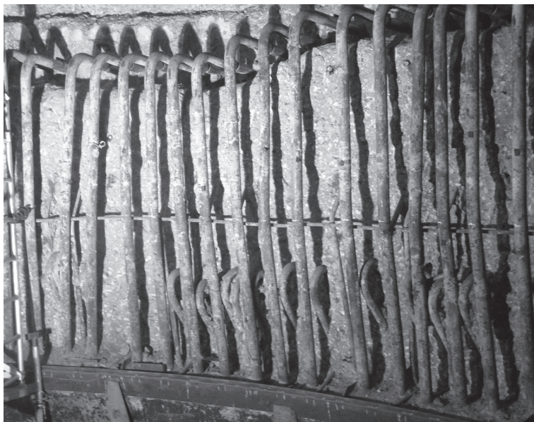
Рис. 2. Материковый бетон конуса отсасывающей трубы. Вертикальная рабочая арматура \varnothing 66 мм
