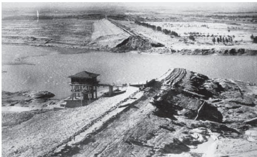
Рис. 1. Разрушенная плотина Баньцяо
