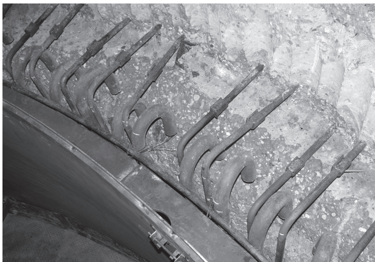
Рис. 3. Область бетонирования конуса отсасывающей трубы с установленной стальной облицовкой
