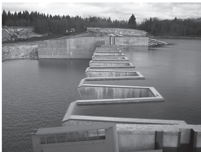
Рис. 3. Водосливная плотина Хоробровской ГЭС
