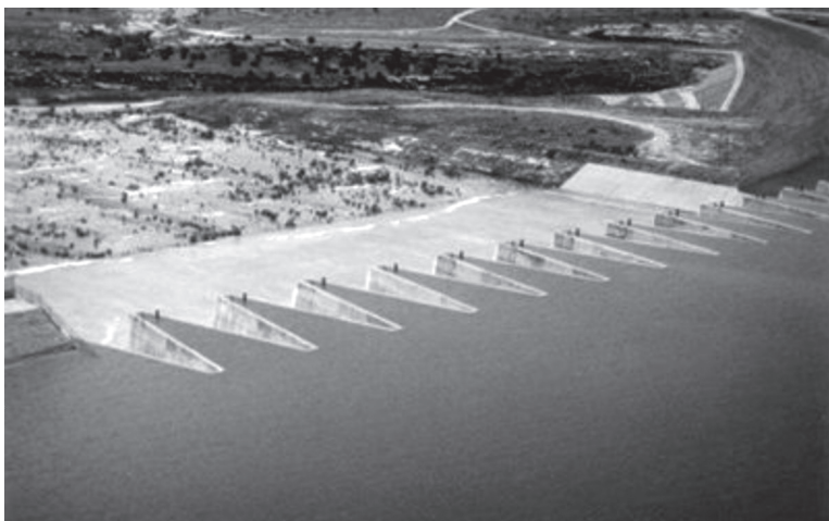
Рис. 1. Лабиринтный водослив на плотине Ute, Нью-Мексико, США
