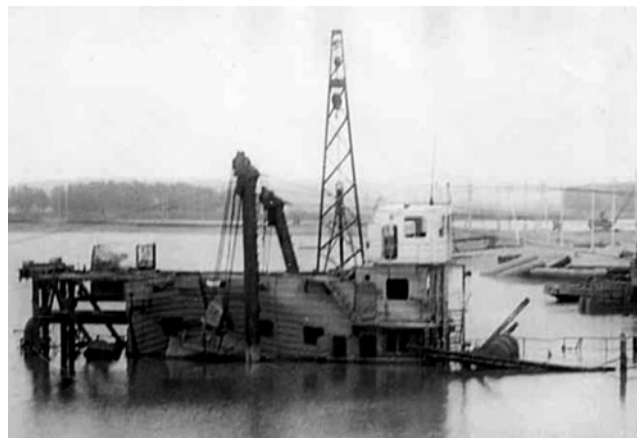
Рис. 4. Поднятый в 1985 г. на строительстве Кайшядорской ГАЭС земснаряд 350 – 50Л
