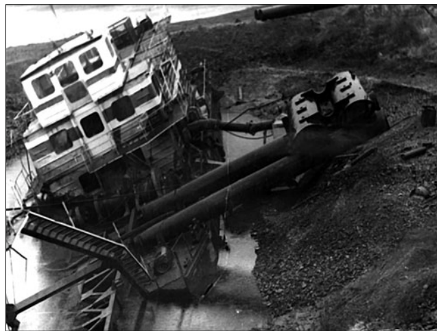
Рис. 2. Перед подъемом земснаряда 350–50Л, затонувшего у берега со значительным креном
