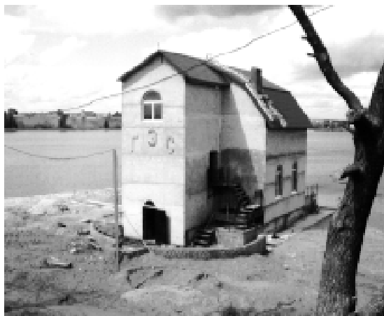
Рис. 1. Здание ГЭС экспериментального гидроветроэнергетического комплекса «Сенеж»
