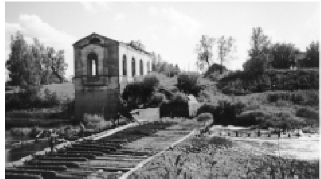
Рис. 4. Здание Мирславльской МГЭС
