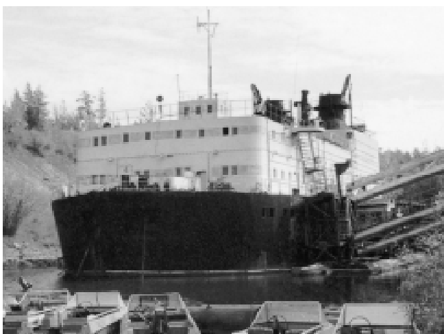
Рис. 1. Эльдикан, ПЛЭС «Северное сияние». Оснащена двумя ГТУ суммарной мощностью 24 МВт, двумя ДГА-315 для собственных нужд и четырьмя котлами общей паропроизводительностью 48 т/ч для отопления поселка Эльдикан.
