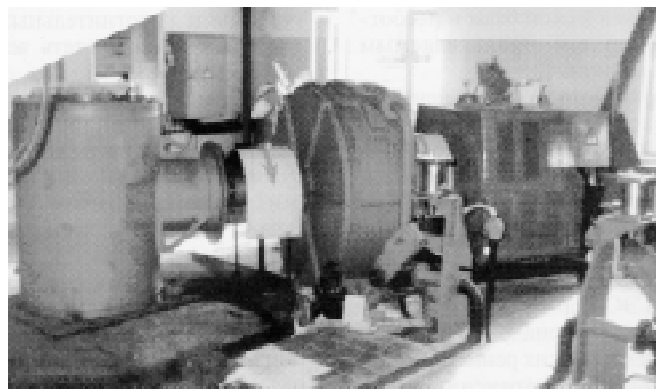
Кабардино-Балкария. МГЭС Акбаш. С горизонтальными агрегатами и пропеллерными турбинами мощностью 500 кВт
