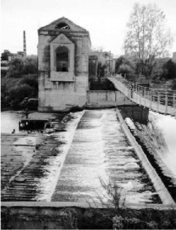
Рис. 2. Деревянный водосброс и здание Петровской МГЭС
