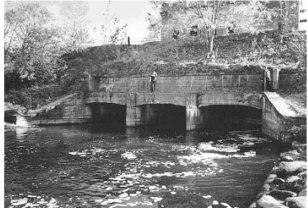
Рис. 3. Нижний бьеф за водосбросными сооружениями Копылковской МГЭС
