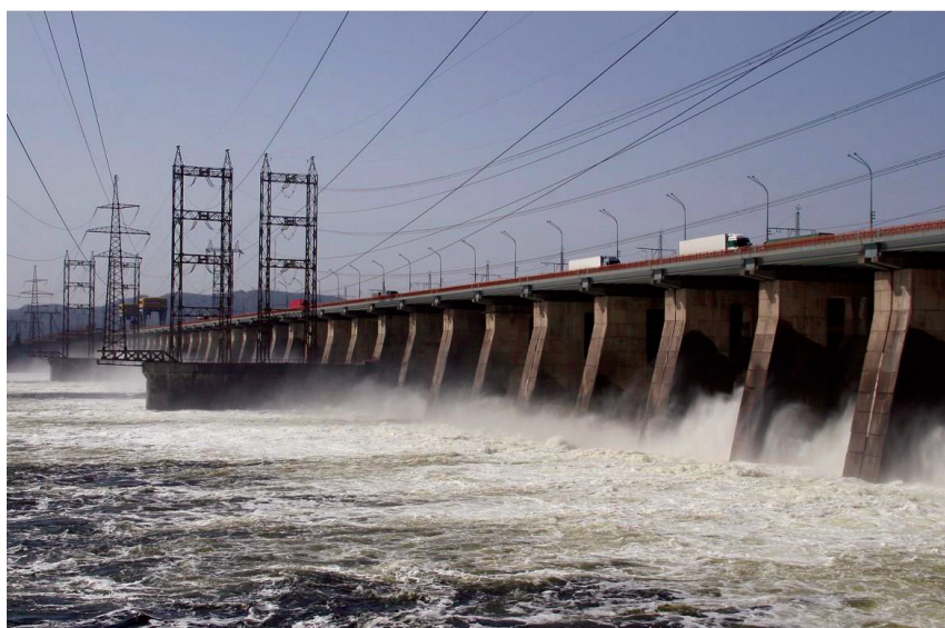
Рис. 12. Водосливная плотина Жигулевской ГЭС
