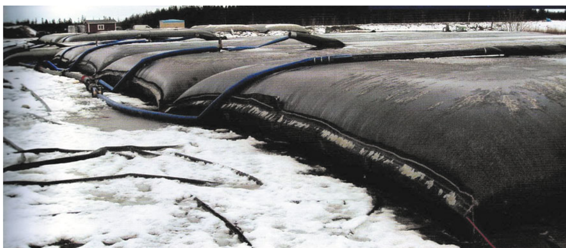
Рис. 2. Заполнение контейнеров (мешков) Geotube® гидросмесью
