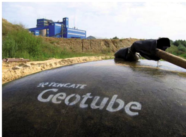
Рис. 9. Ввод питающего рукава в контейнер
