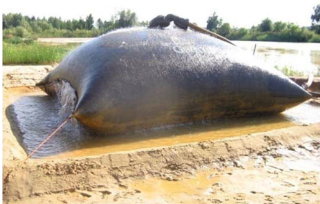
Рис. 10. Контейнер Geotube® на момент прекращения закачки (12.08.2011)
