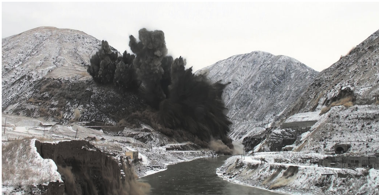
Рис. 2. Крупномасштабный взрыв для возведения плотины
