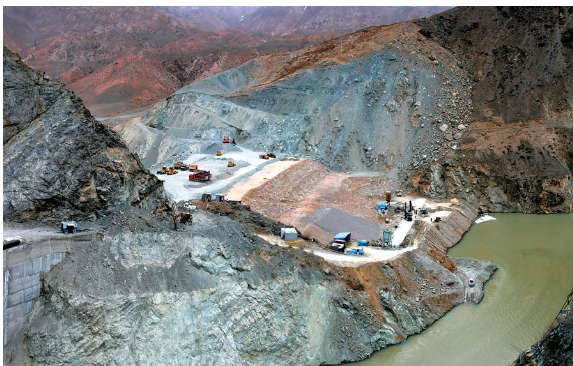
Рис. 5. Достройка плотины (март 2010 г.)
