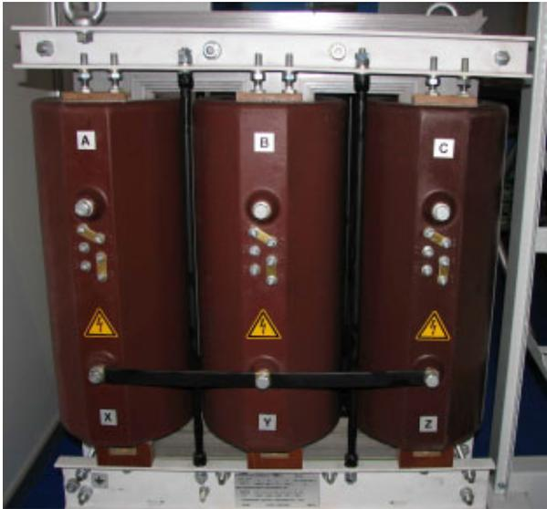
ческие свойства с предельно низким уровнем возникновения частичных разрядов. Кроме этого, литая обмотка дает возможность в небольших габаритных размерах получить мощные сухие трансформаторы для использования в сетях с более высоким уровнем напряжения.
