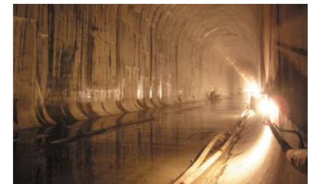
Рис. 3. Проблема трещинообразования в обделке тоннеля берегового водосброса СШ-ГЭС
