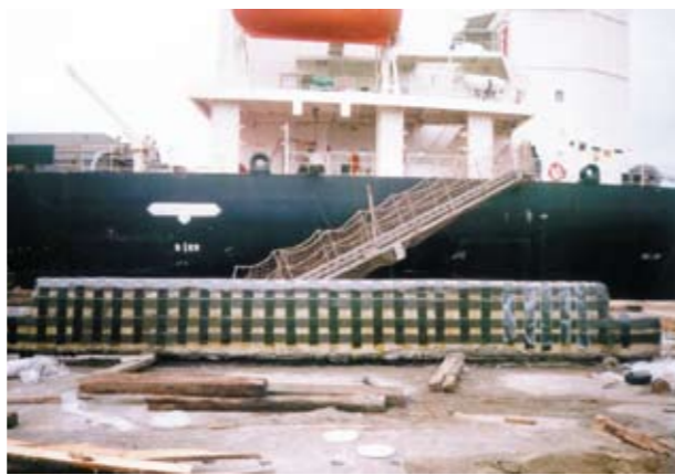
Рис. 4. Ремонт и усиление бортовой балки
