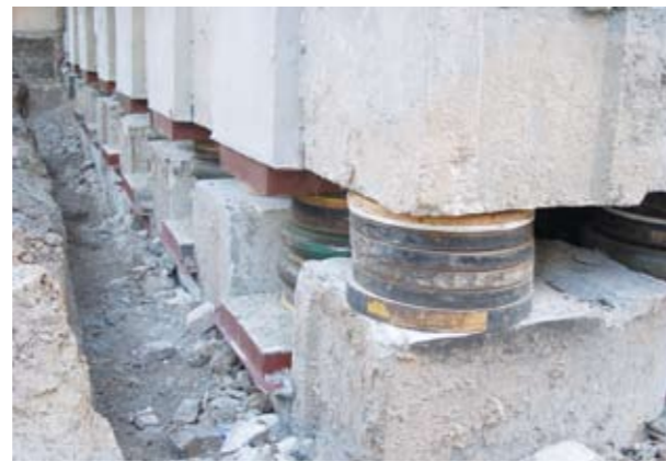
Рис. 11. Регулируемый фундамент в виде точечных распределительных железобетонных элементов в домкратных проемах, Ростов-на-Дону
