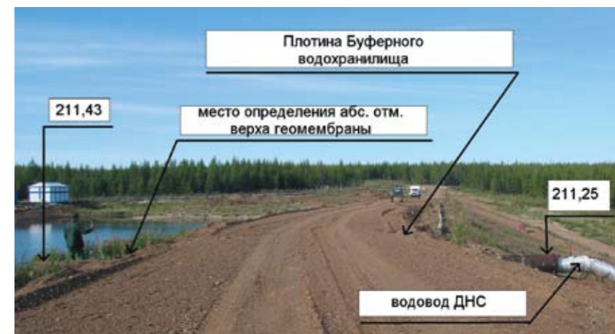
Фото 1. Плотина на гребне
