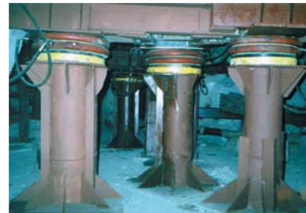
Рис. 12. Регулируемый фундамент в виде точечных опорных элементов под домкратный пакет по сваям усиления
