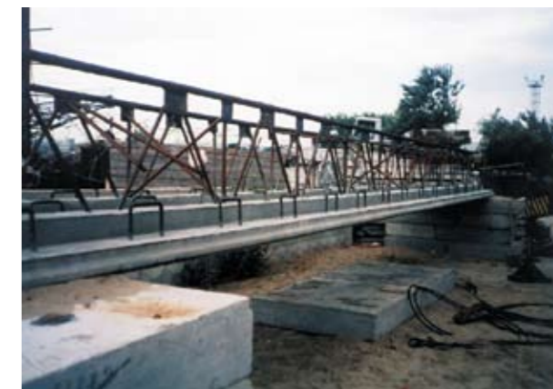
Рис. 6. Опалубочная плита с фермами
