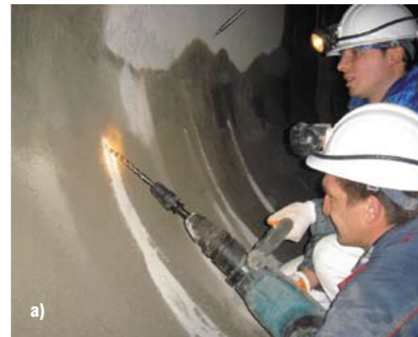
Рис. 7. Фиксация момента выхода инъекционного материала из трещины в процессе проведения работ
