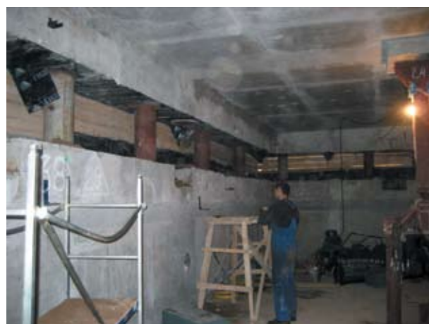
Рис. 3. Вид подвальной части после подъема
