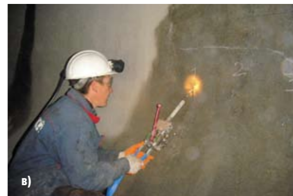
Рис. 6. Технология инъектирования трещин:
