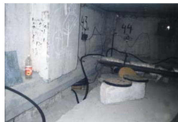
Рис. 7. Конструктивное решение регулируемого фундамента 9-этажного жилого дома в г. Волгодонске. Железобетонный пояс по балочному типу
