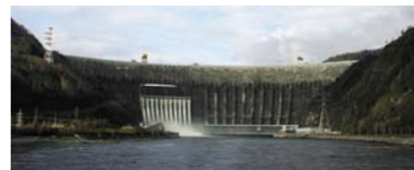
Рис. 1. Саяно-Шушенская ГЭС им. П. С. Непорожного
