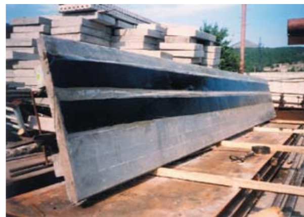
Рис. 5. Изготовление опалубочной плиты, усиленной углепластиковыми накладками
