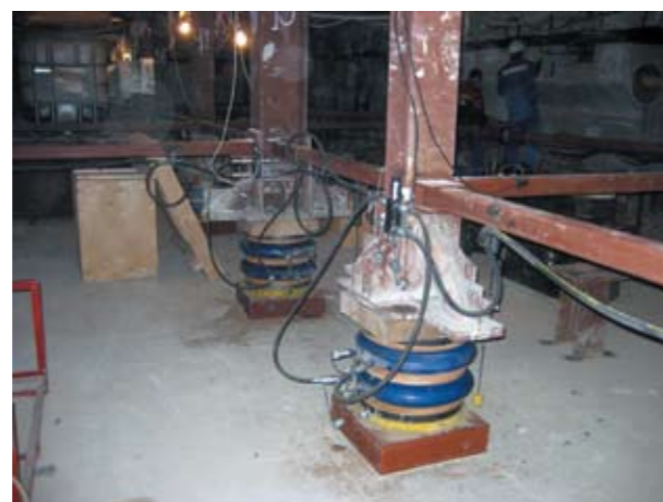
Рис. 5. Здание в процессе подъема. Домкраты установлены под колоннами
