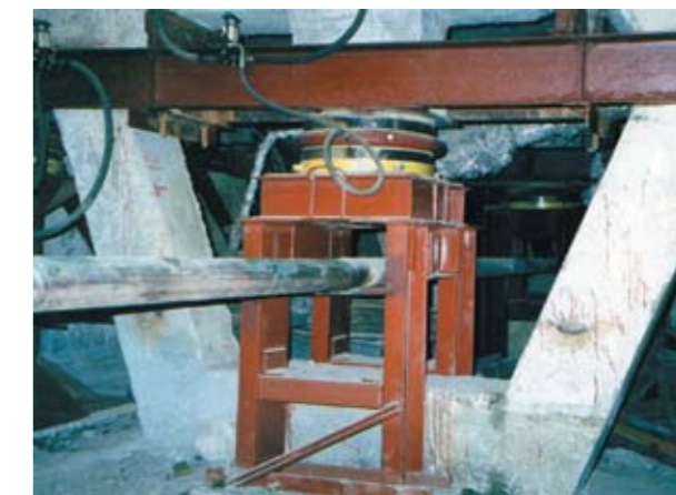
Рис. 9. Фрагмент регулируемого фундамента с опорным столиком, г. Белово, Кемеровская обл.
