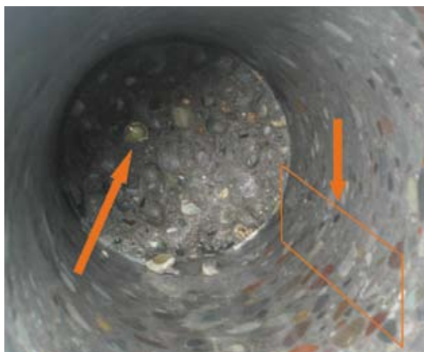
Рис. 5. Выбуривание кернов на месте проведенных инъекционных работ (обозначены видимые места заполнения трещины инъекционным материалом)
