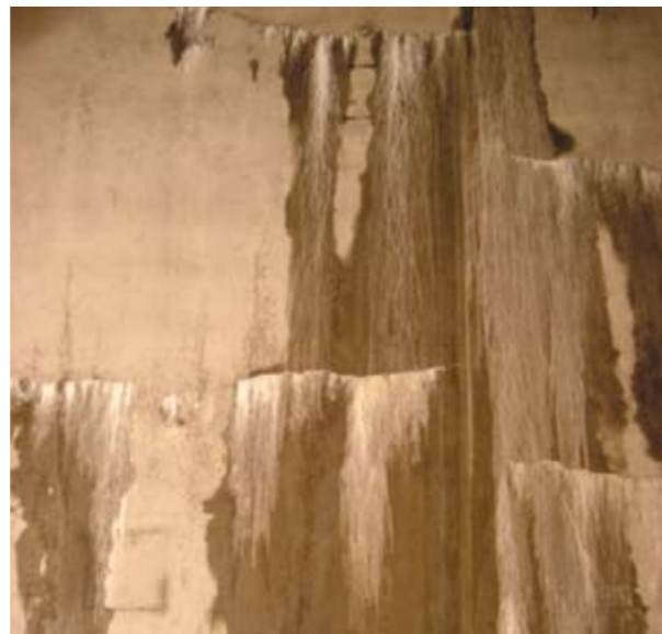
Рис. 4. Фильтрация воды и высолообразование на поверхности обделки тоннеля
