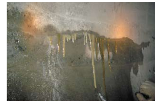
Рис. 7. Фиксация момента выхода инъекционного материала из трещины в процессе проведения работ
