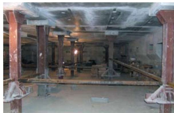
Рис. 4. Колонны под зданием на стадии строительства. Предусмотрены регулируемые фундаменты под колоннами
