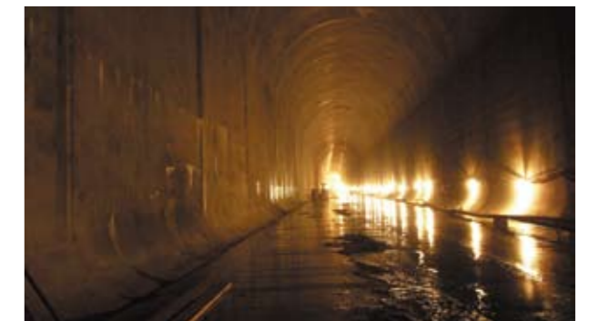
Рис. 2. Правый тоннель берегового водосброса СШ-ГЭС
