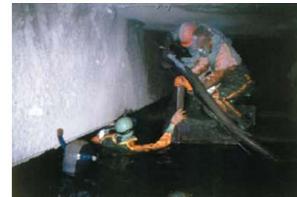
Рис. 2. Восстановление поврежденных конструкций причала методом торкретирования
