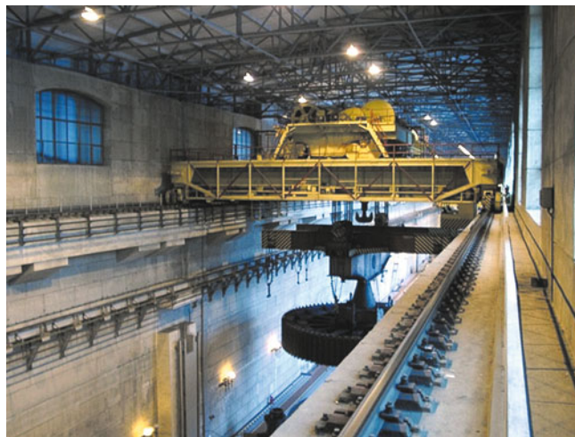
Рис. 2. Проведение испытаний консолей подвижной нагрузкой
