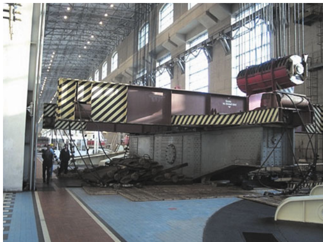
Рис. 3. Испытание перекрытия машинного зала статической нагрузкой
