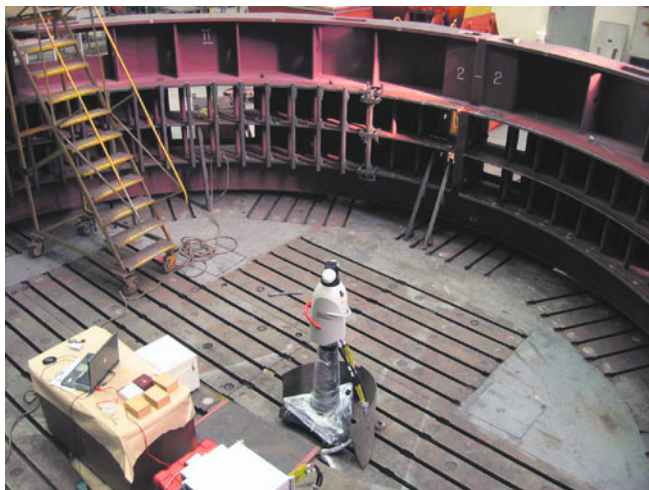
Рис. 6. Разгонка клиньев статора гидрогенератора СВ 783/105 – 40УХЛ4 с применением абсолютного лазерного трекера “Leica AT901”
