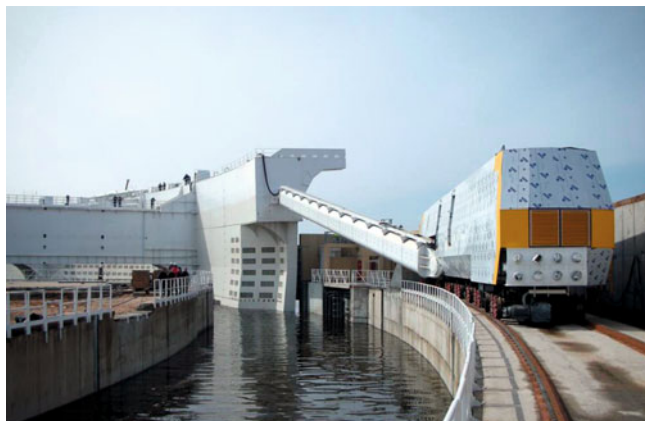
Рис. 7. Привод батопорта. Вывод батопорта из доковой камеры
