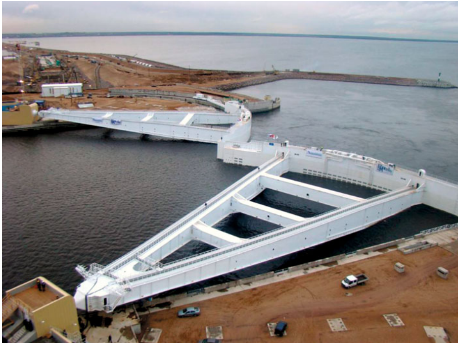
Рис. 8. Перекрытие канала сооружения С-1 при испытаниях затвора
