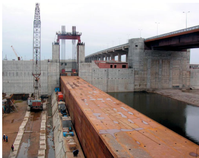
Рис. 4. Подъем затвора оборудованием фирмы "VSL"
