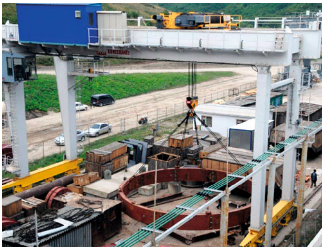
Рис. 1. Сборка щита кольцевого затвора на монтажной площадке
