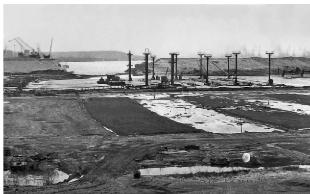
Рис. 12. Наплавные секции подводного Канонерского туннеля перед выводом через прорез шлюза в Ленинградский канал (сзади секций строительное место шлюз-дока).
