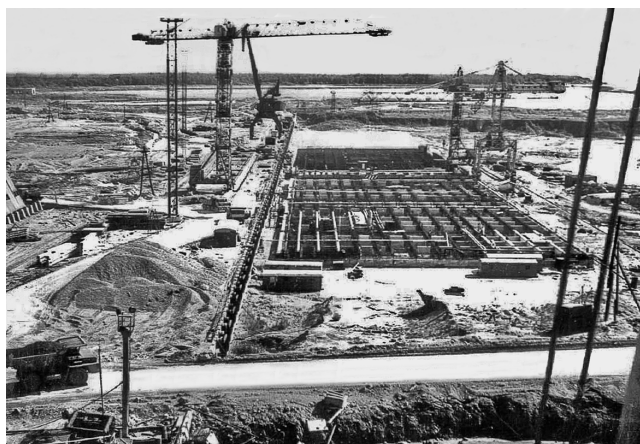
Рис. 10. Общий вид котлована аванпорта Санкт-Петербургской защитной дамбы. Изготовление у причальной стенки котлована крупных наплавных блоков русловых водопропускных сооружений дамбы
