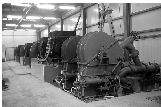
Рис. 5. МГЭС «Фаснал», сдвоенные гидротурбины ГА10, Северная Осетия
