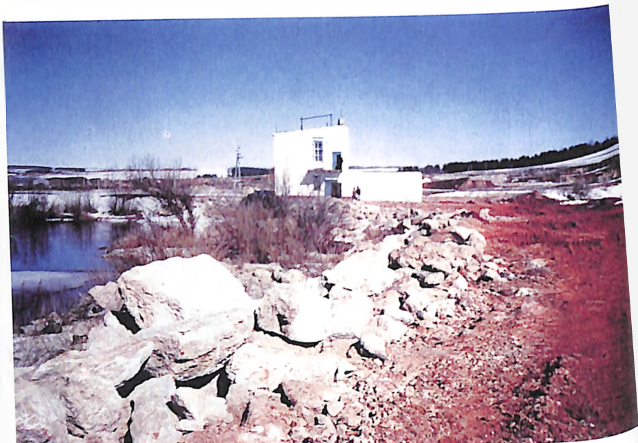
Здание Ичалковской ГЭС. Вид с переливной дамбы.
