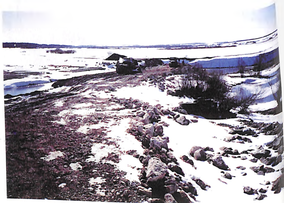
Переливная дамба (ремонт левобережного примыкания).
