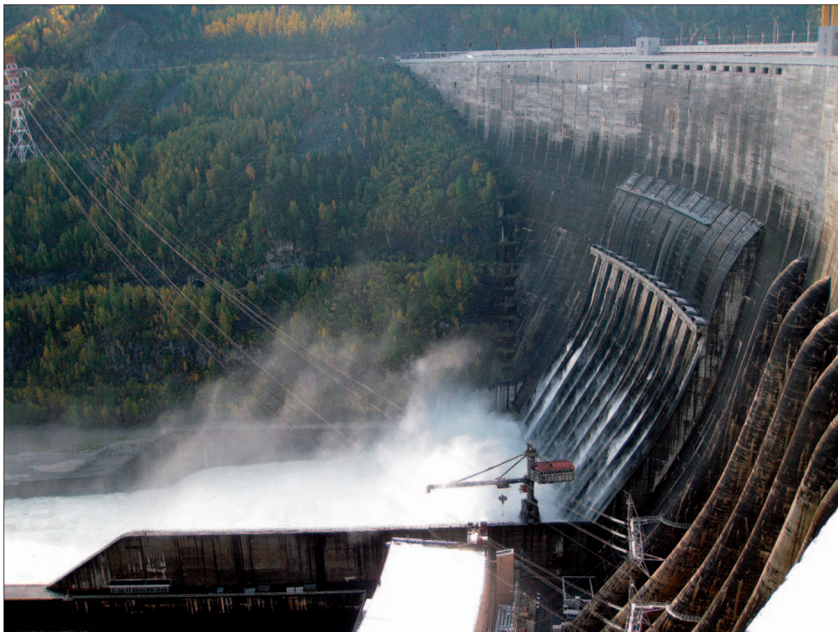
Рис. 7. Работа водосброса при открытии 11 пролетов на первой ступени (0,25 от полного открытия)
