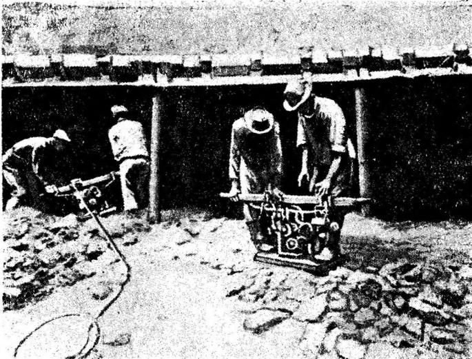
Рис. 11. Применений вибраторов платформенного типа на плотине Кэльдервуд.
