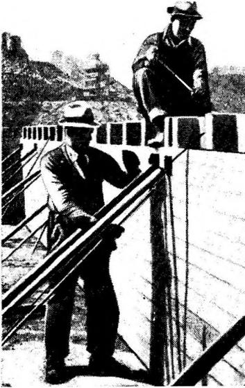
Рис. 20. Установка щитов опалубки и укрепление ос стяжками и подпорками из газовых труб.
