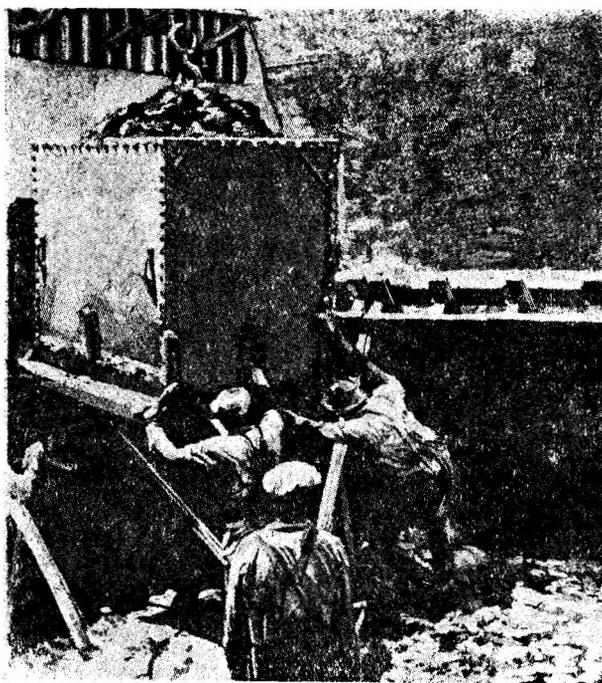
Рис. 10. Укладка бетона на плотине Кэльдервуд — ковш на 4 куб. ярда (3,10 м<sup>3</sup>).
