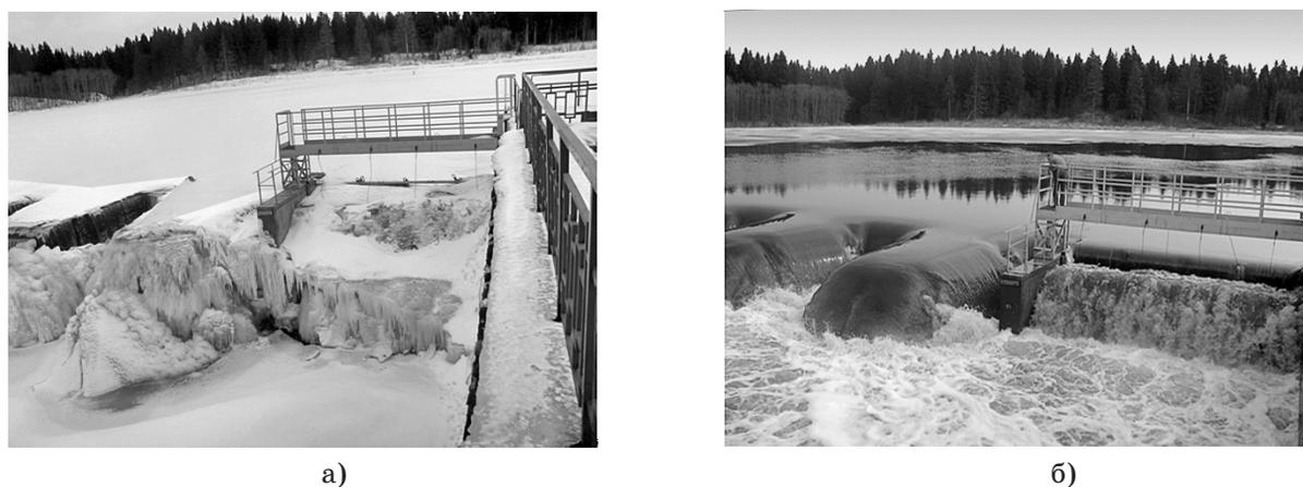
Рис. 6. Автоматические затворы многоразового действия на Хоробровской МГЭС: а — эксплуатация в зимних условиях; б — пропуск паводка
