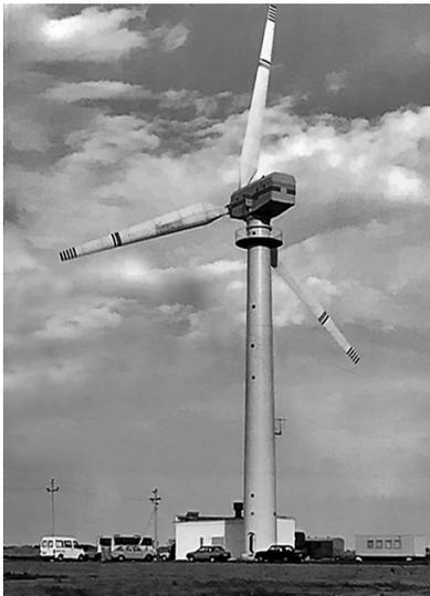
**Рис.** Ветроэлектрическая установка ВЭУ «РАДУГА-1» 17 номинальной мощностью 1 МВт с диаметром ветроколеса 48 м и высотой башни 36 м
