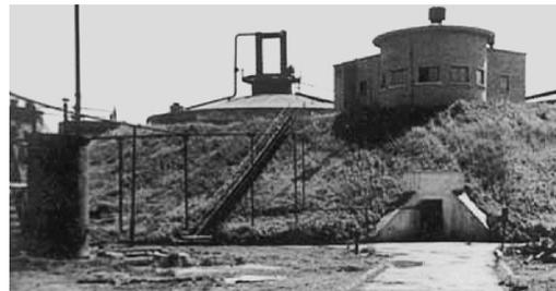
Рис. 15. Метантенк объемом 4500 м<sup>3</sup>,
