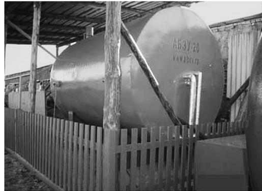
Рис. 11. Метантенк теплоэлектростанции АБЭУ-20. Мощность 3.3 кВт (эл.) и 7.1 кВт (тепл.) Биореактор-метантенк 20 куб. м. Комплекс КРС, пос. «Горелое» Тамбовской обл. ЗАО «СИГНАЛ»
