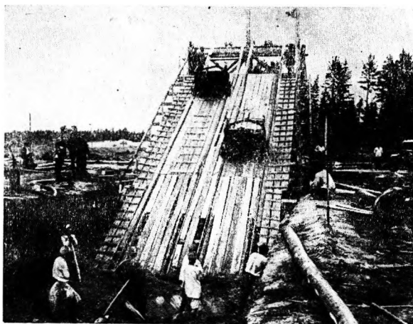
Фиг. 77. Общий вид эстакады землетаски со сплошным настилом.
