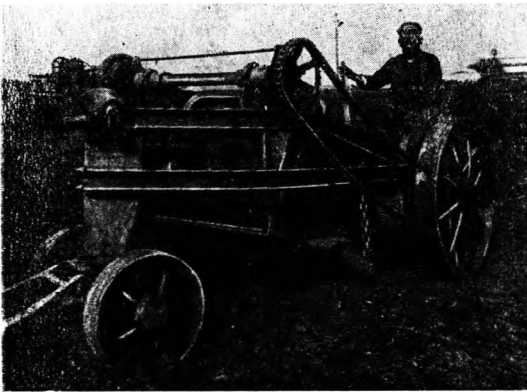
Фиг. 87. Тракторная лопата типа Беккера.
