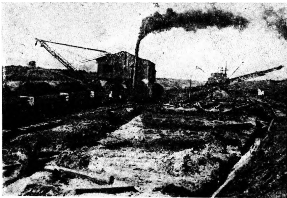
Фиг. 70. Совместная работа экскаваторов Любек Е-1 и Любек 405, из которых первый работает на вымет, а второй — с железнодорожным транспортом.
