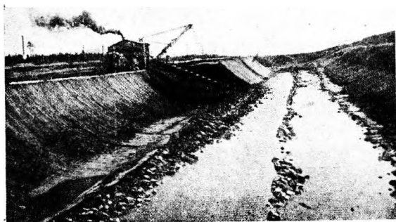
Фиг. 68. Экскаватор Любек 405, работающий с отвозкой грунта по железной дороге нормальной колеи.
