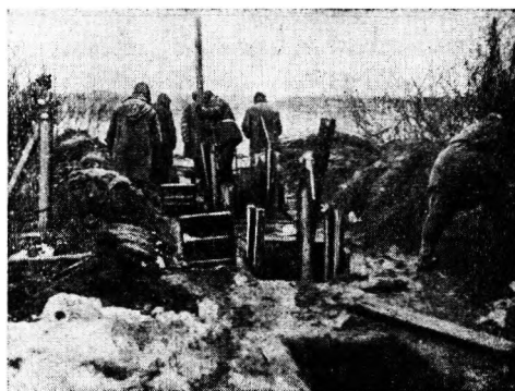
Фиг. 122. Изготовление минных колодцев при взрывах на выброс на р. Клязьме.
