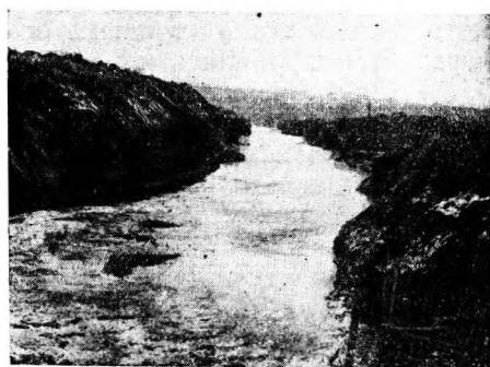
Фиг. 121. Спрямление р. Химки взрывами: а — момент взрыва; б — спрямленный участок реки.
