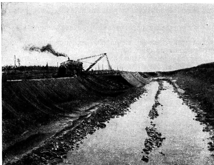
Фиг. 36б. Работа экскаватора Любек на выемке Лесозаводского бугра.
