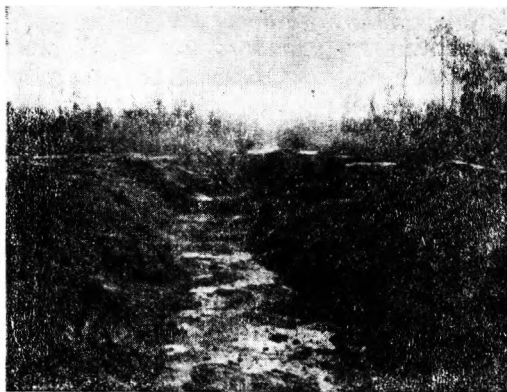
Фиг. 115. Результат взрывов низовой части канавы.
