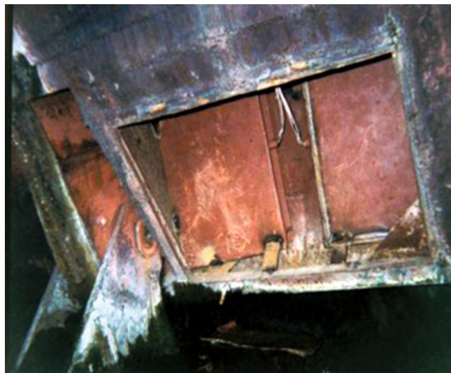
Рис. 11. Нагреватель на основе КРМ, установленный на клапанном затворе ледосброса Нарвской ГЭС-13
