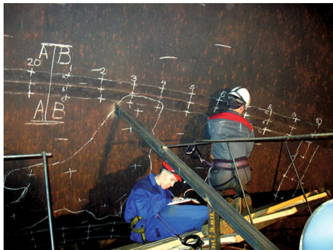
Рис. 2. Обследование металлических конструкций на Саяно-Шушенской ГЭС
