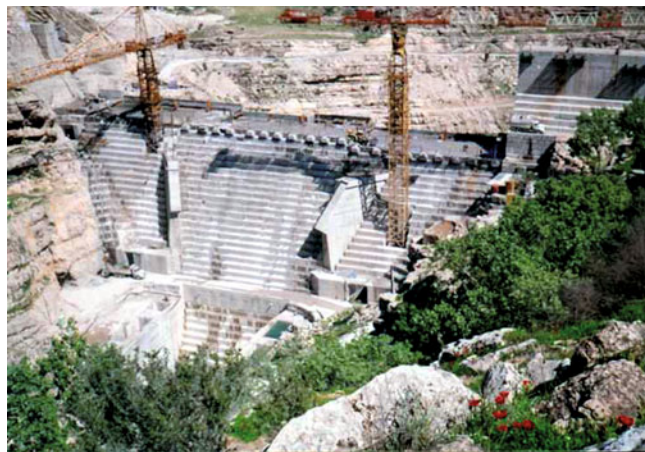
Рис. 6. Современный метод бетонирования плотин (плотина Коусар высотой 144 м)
