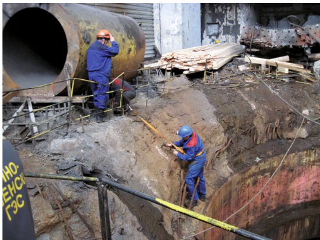
Рис. 1. Обследование бетонных конструкций на Саяно-Шушенской ГЭС
