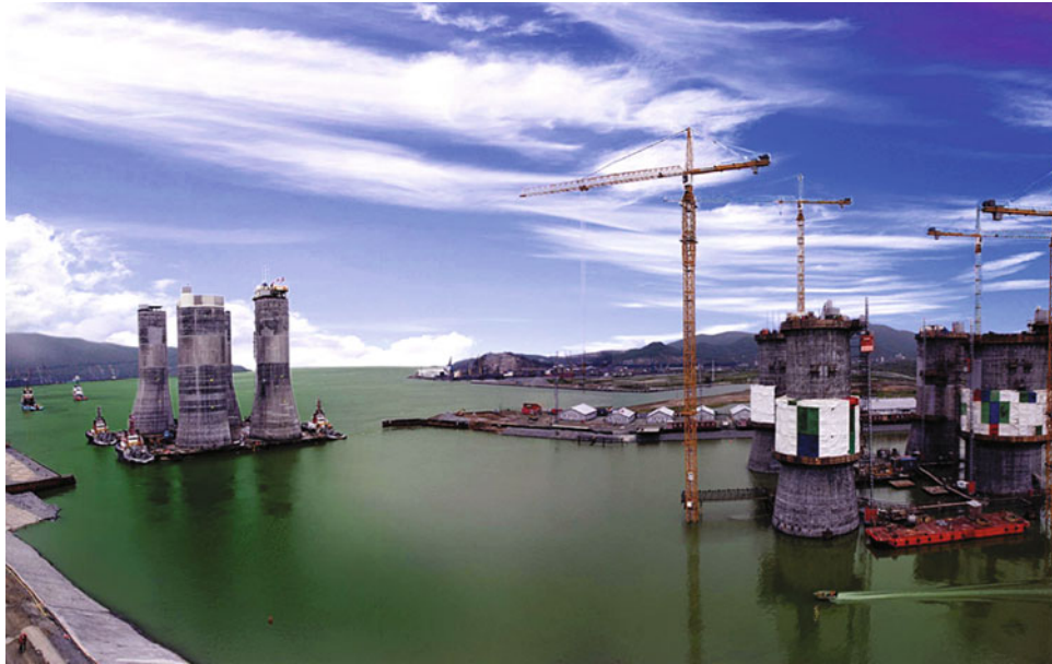
Рис. 4. Транспортировка железобетонного основания для установки на месторождение
