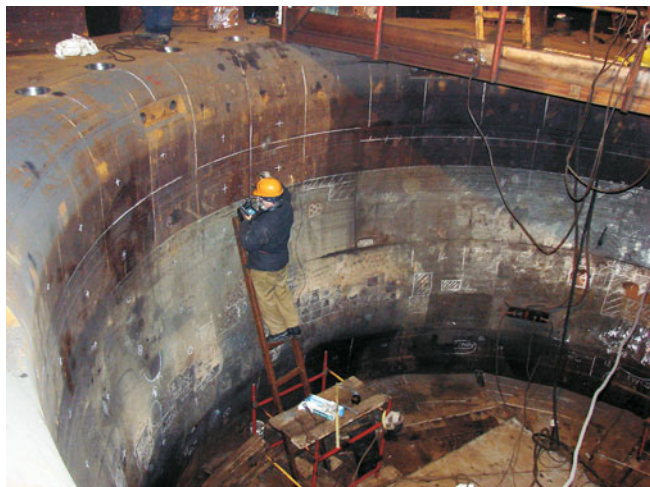
Рис. 3. Обследование КРК на Иркутской ГЭС
