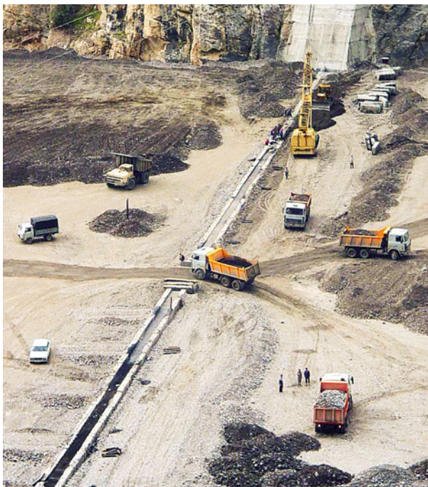
Рис. 1. Общий вид строительства литой асфальтобетонной диафрагмы грунтовой плотины Ирганайской ГЭС
