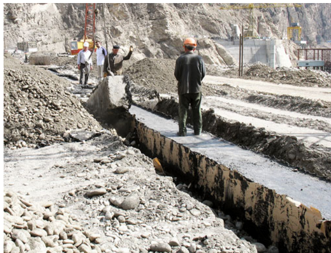
Рис. 2. Разборка железобетонной опалубки литой асфальтобетонной диафрагмы Ирганайской ГЭС
