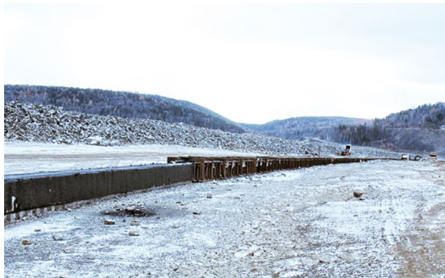
Рис. 6. Вид яруса литой асфальтобетонной диафрагмы плотины Богучанской ГЭС с частично снятой металлической опалубкой
