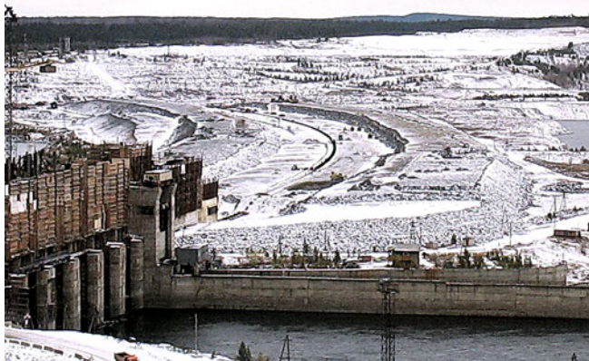
Рис. 4. Общий вид на строительство литой асфальтобетонной диафрагмы каменнонабросной плотины Богучанской ГЭС
