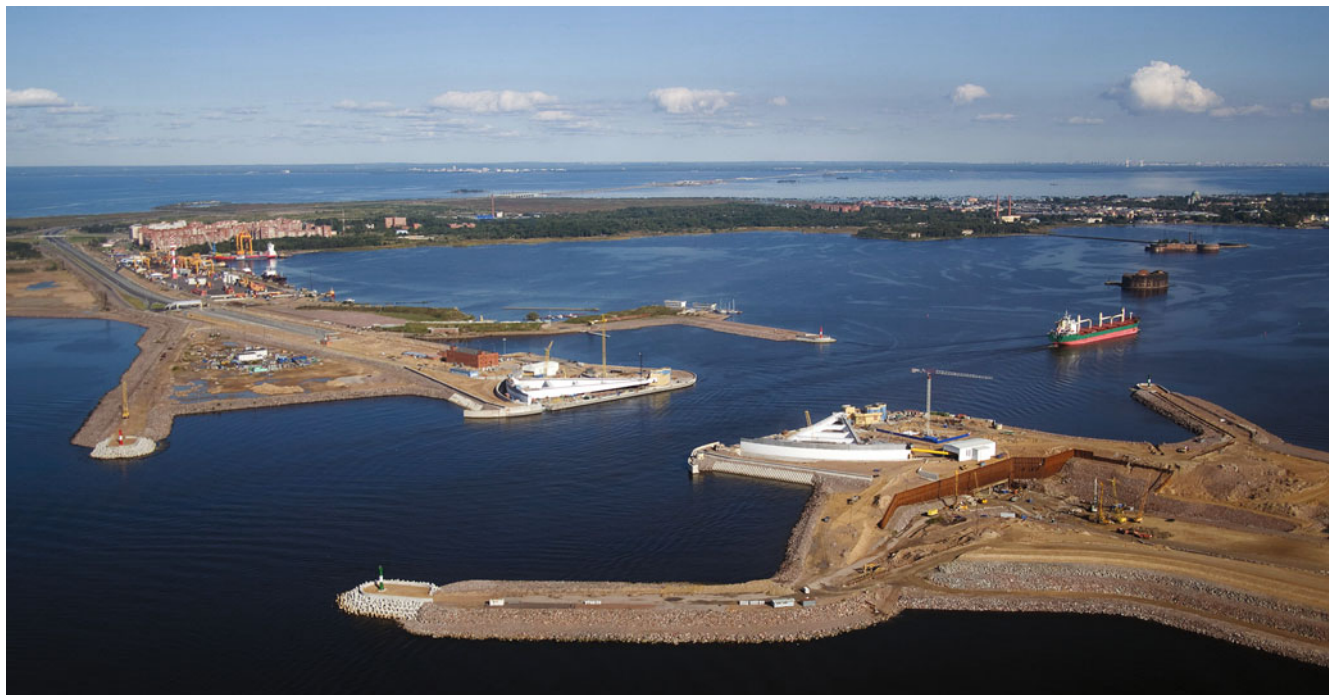
Рис. 3. Общий вид КЗС с судопропускным сооружением С-1
