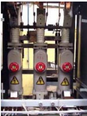
К недостаткам малообъемных масляных выключателей можно отнести их пожаро- и взрывобезопасность. Ограниченная способность к быстрдействию и частоте осуществления АПВ. Эксплуатация таких выключателей обходится дороже: замена и периодическая доливка масла, износ дугогасящих контактов, текущие ремонты. При работе МВ на низких температурах могут возникнуть трудности с подогревом масла. Отключающая способность масляных выключателей может оказаться недостаточной.
