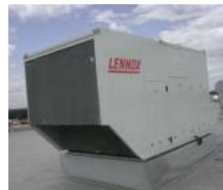
и исключить возможность попадания воздуха с выхода на вход вентилятора. Необходимо также обеспечить свободный доступ для проведения монтажных, пусконаладочных, эксплуатационных и ремонтных работ.
