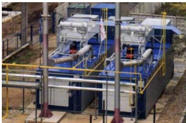
лообеспечения, — объясняет Ольга Соколова. — В отличие от раздельно используемых энергетических установок и котлов номинальный общий КПД когенератора увеличивается до 92%.
