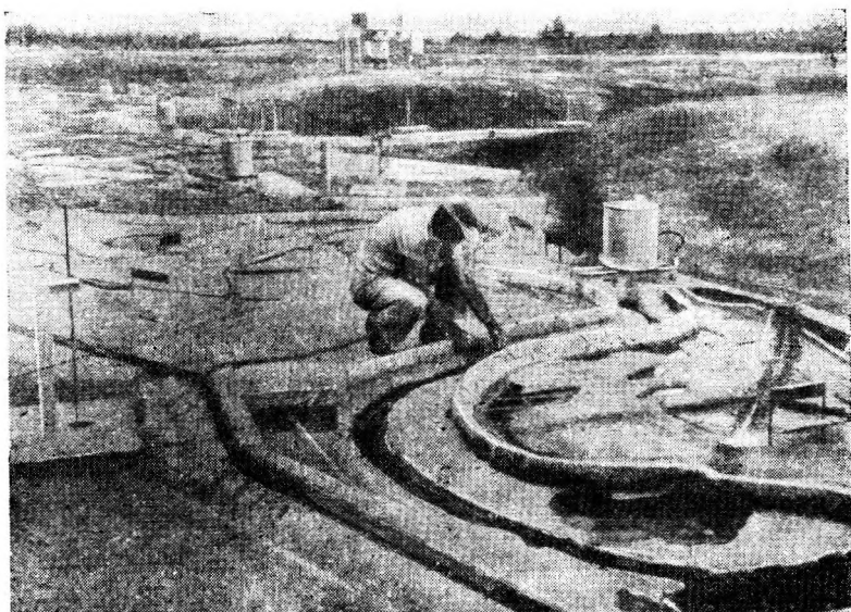
Рис. 19. Большая гидравлическая модель р. Миссисипи с неразмываемым дном.
