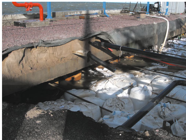
Рис. 8. Заполнение провалов мешками с песком
