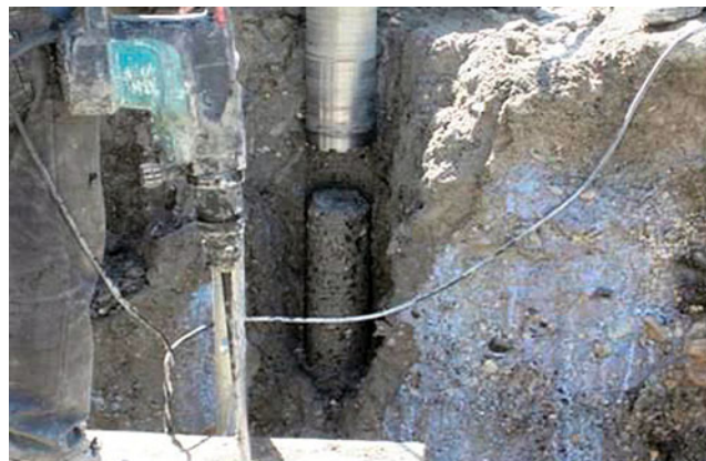
Рис. 8. Подъём керноприемника перед отделением керна от массива свай
