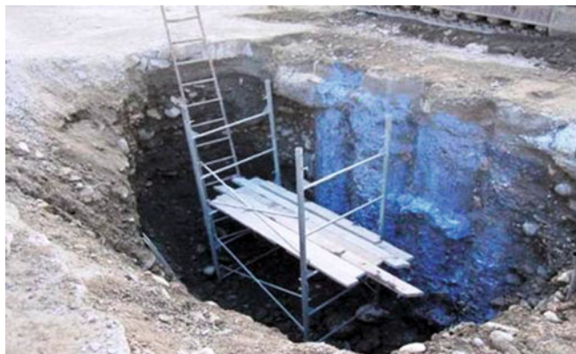
Рис. 7. Шурф фрагмента 1: видна поверхность свай
