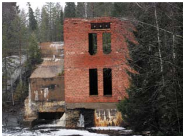
Рис. 1. Вид на здание и подводный канал гидроэлектростанции Рюмякоски на р. Тохмайоки
