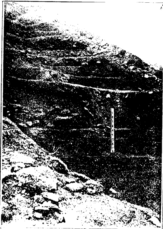
Abb. 2 Schürfung auf der Wasserseite mit photographierter Schichtenhöhe. Böschungspflaster.
