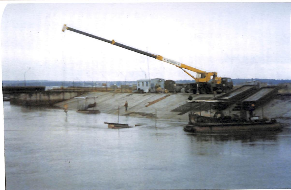
Установка под воду арматуры и щитовой опалубки для подводного бетонирования
