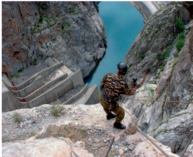
Рис. 3. Установка отражателя на трещинах массива № 59-1
