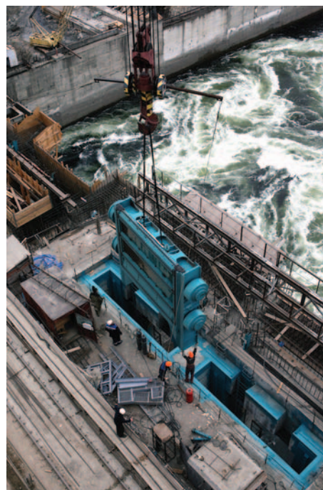
Рис. 2. Монтаж затворов на Богучанской ГЭС
