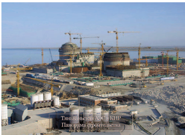
Рис. 18. Строительство Тяньваньской АЭС в КНР
