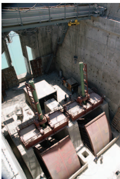
Рис. 9. Монтаж гидроприводов сегментных затворов на Сангтудинской ГЭС (Республика Таджикистан)
