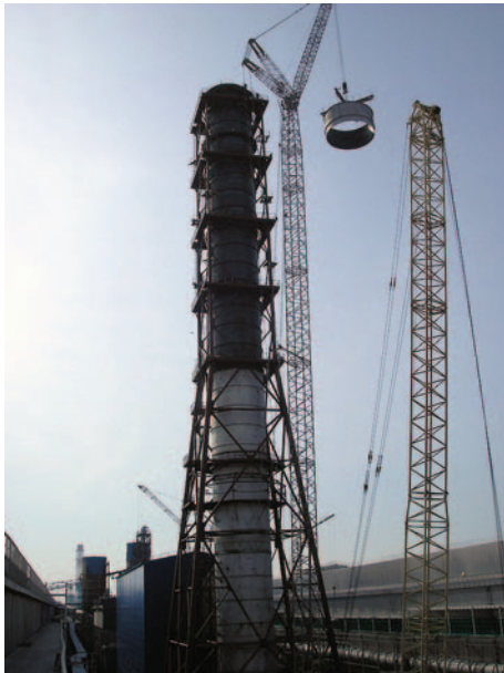
Рис. 11. Монтаж трубы газодымоудаления на Хакасском алюминиевом заводе
