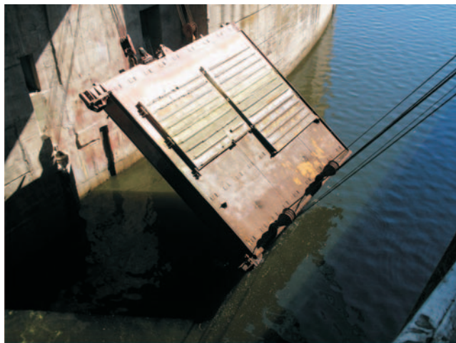
Рис. 3. Кантовка створки в воздухе четырьмя полиспастами
