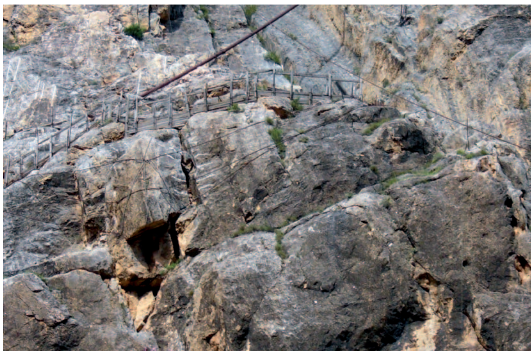
Рис. 14. Тросовое крепление одного из скальных блоков в массива № 59-1
