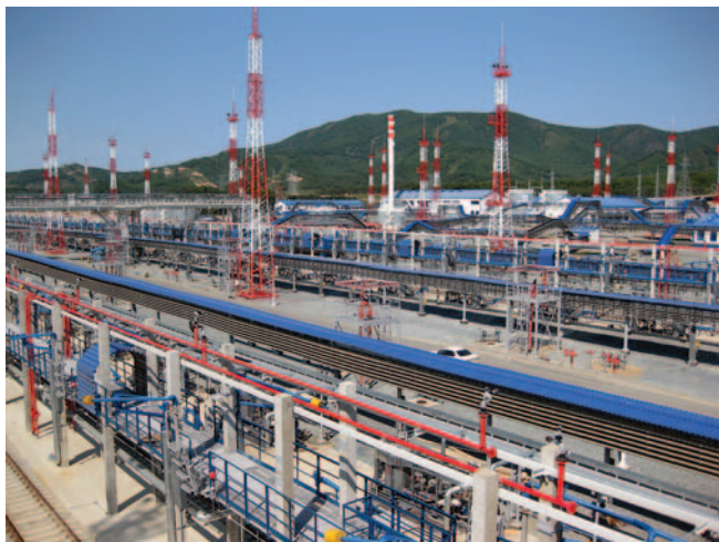
Рис. 7. Строительство нефтепорта Козьмино
