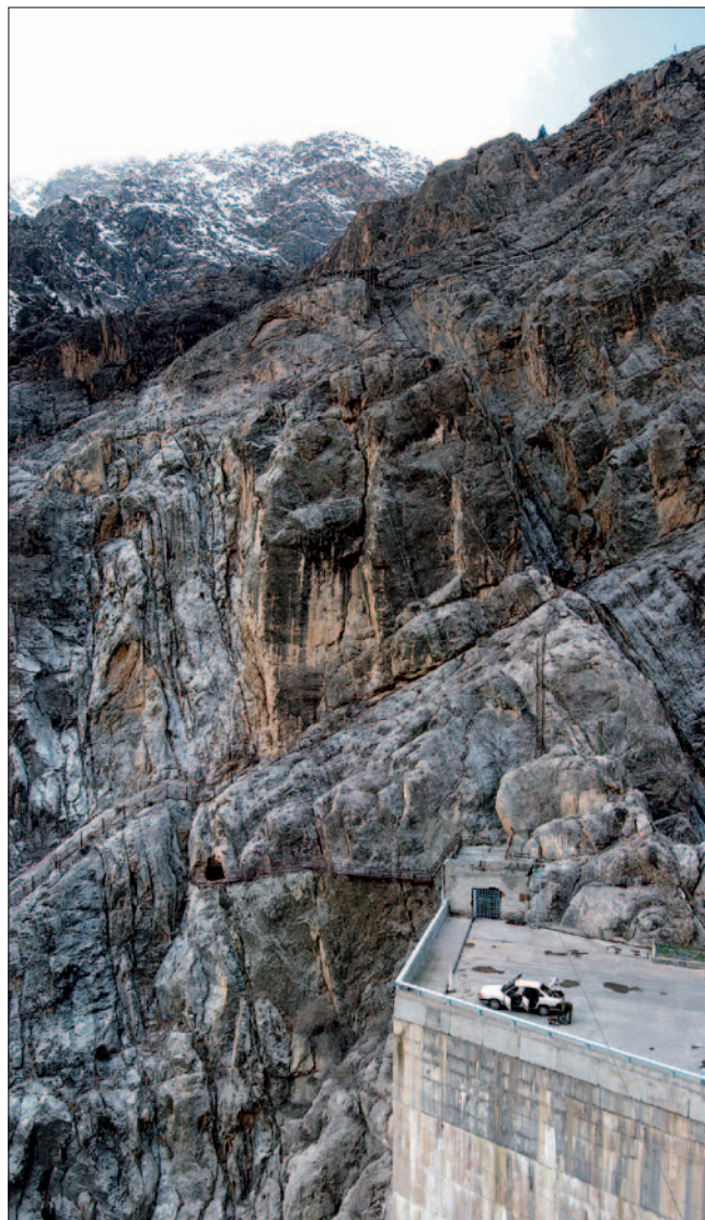
Рис. 1. Потенциально неустойчивый массив № 59-1 в правобережном примыкании бетонной плотины Токтогульской ГЭС
