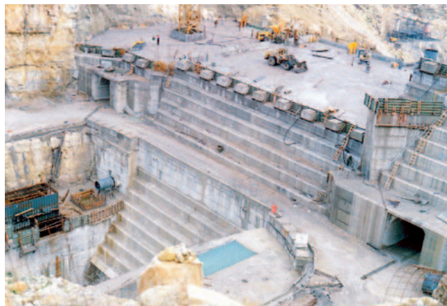
Рис. 4. Плотина Коусар высотой 144 м со ступенчатым водосбросом во время строительства, 2004 г.
