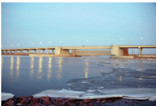
Рис. 17. Комплекс защиты г. Санкт-Петербург от наводнений, судопропускное сооружение С-2
