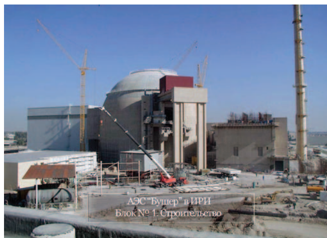
Рис. 3. Строительство блока № 1 АЭС Бушер в Иране
