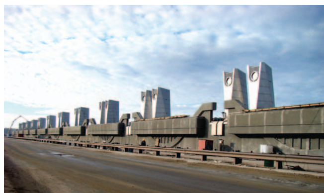
Рис. 5. Комплекс защиты г. Санкт-Петербург от наводнений, гидроподъемники затворов водопропускных сооружений
