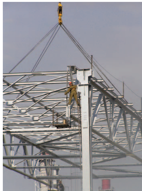
Рис. 8. Монтаж цеха Тайшетского алюминиевого завода
