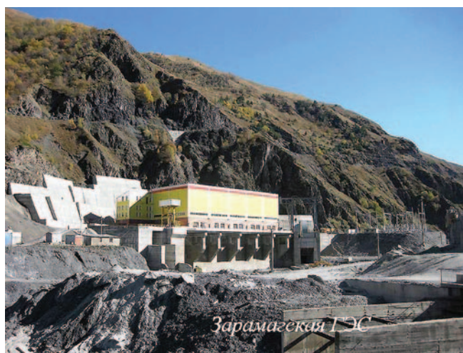
Рис. 6. Строительство Зарамагской ГЭС (Республика Северная Осетия-Алания)
