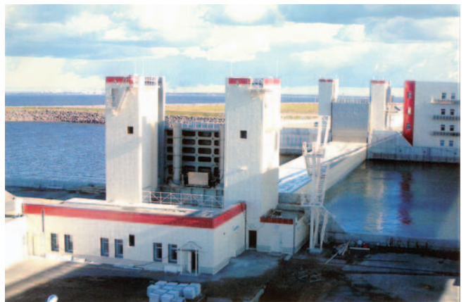
Рис. 14. Комплекс защиты г. Санкт-Петербург от наводнений, судопропускные сооружения С-2
