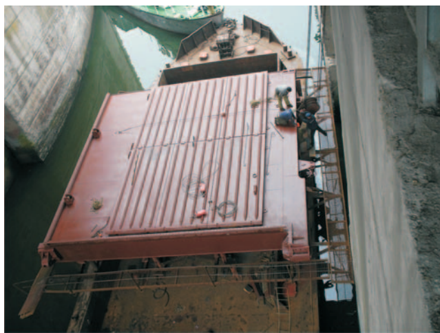
Рис. 1. Доставка новых створок в камеру на специально обустроенной барже
