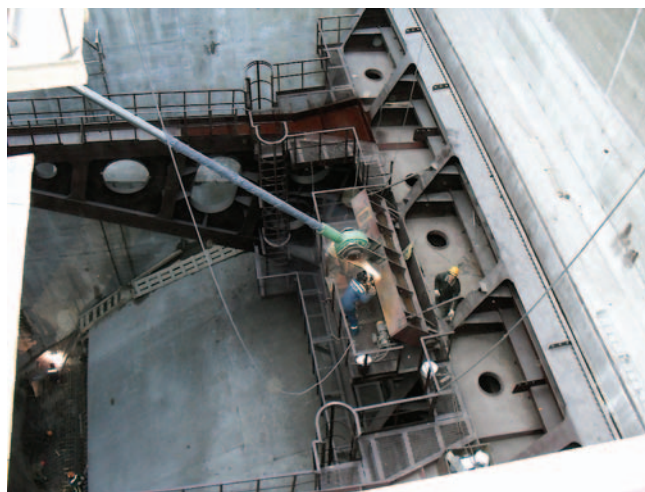
Рис. 10. Монтаж гидропривода сегментного затвора поверхностного водосброса Саяно-Шушенской ГЭС
