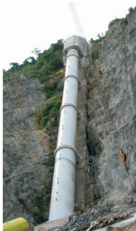
Рис. 1. Крутонаклонный участок трубопровода ГЭС А-Вуонг
