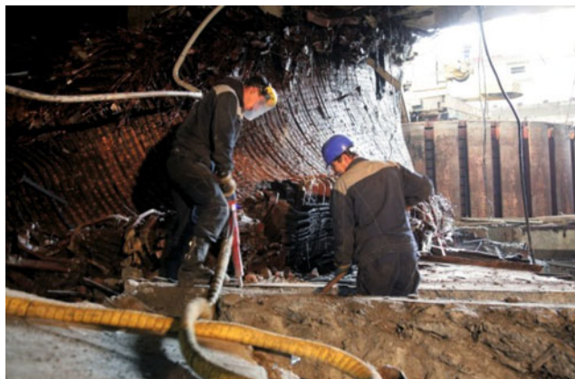
Рис. 4. Вид на генератор 7-го агрегата из подгенераторного помещения
