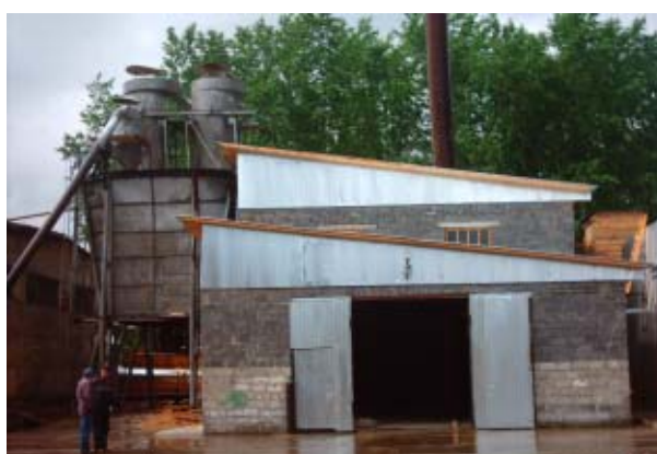
Фото 2. Смонтированная котельная 2,5 МВт с бункером топлива
