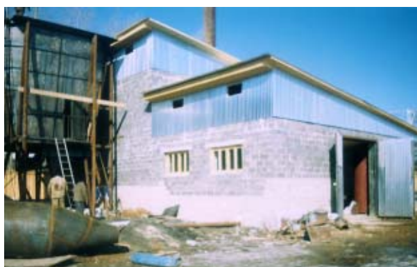
Фото 1. Стройплощадка котельной с бункером топлива и сушильным комплексом
