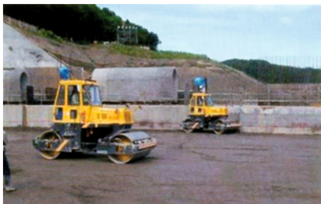
Рис. 12. Уплотнение слоя смеси толщиной 75 см виброкатком 11 т
