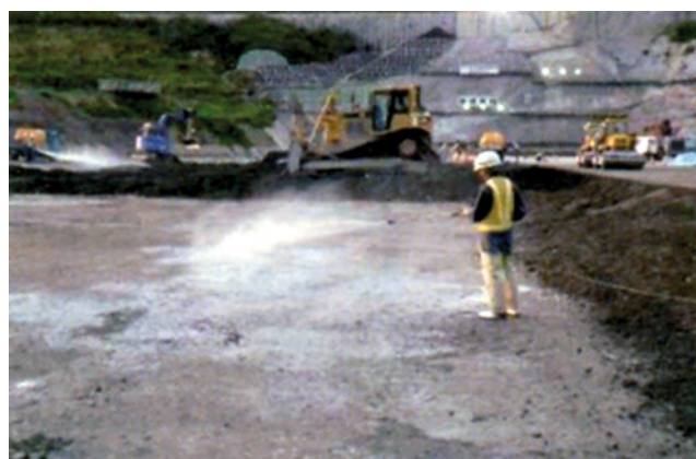
Рис. 8. Промывка уплотненной поверхности предыдущего слоя
