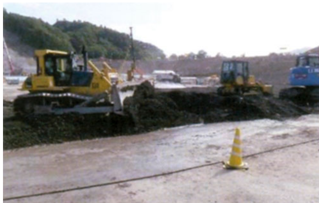
Рис. 11. Разравнивание смеси CSG бульдозером
