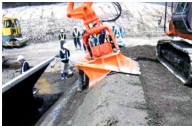
Рис. 13. Формирование откоса зоны CSG и его уплотнение
