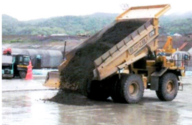
Рис. 10. Разгрузка смеси CSG из автосамосвала грузоподъемностью 55 т
