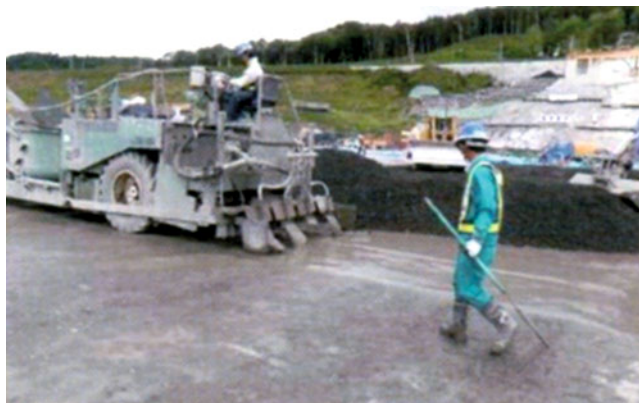
Рис. 9. Распределение цементного раствора перед укладкой нового слоя смеси CSG
