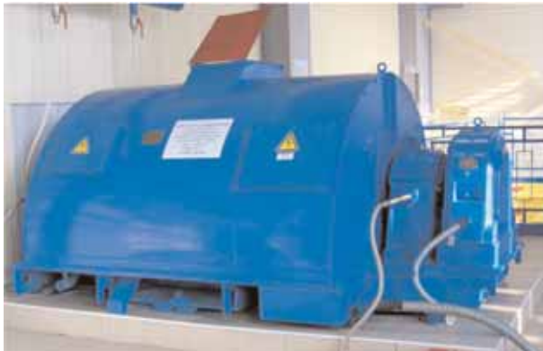
Рисунок 4.1 Синхронный электродвигатель с БВУ (безщёточным возбуждением)
