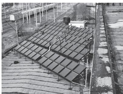
г. Анапа. Установка производительностью 4000 л горячей воды в день
