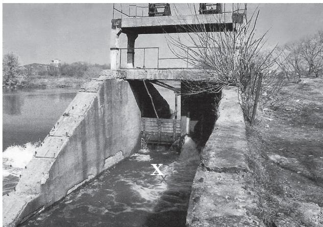
**Рис.1.** Водосбросное сооружение. Вид с нижнего бьефа. X — место установки гидроагрегата после капитального ремонта
