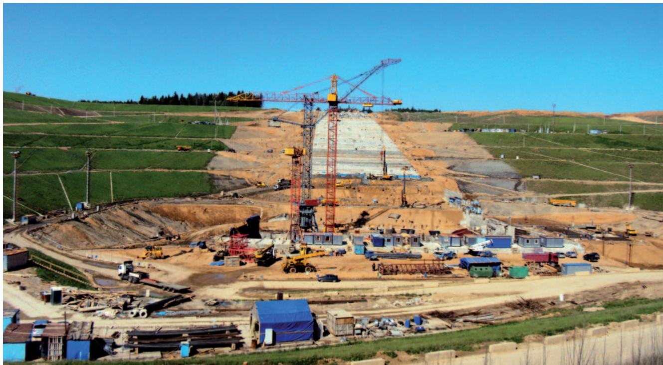
Рис. 4. Строительство здания ГАЭС и напорных водоводов
