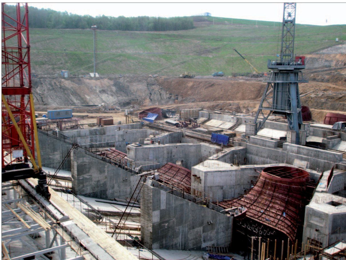
Рис. 5. Здание ГАЭС, монтаж колен отсасывающих труб
