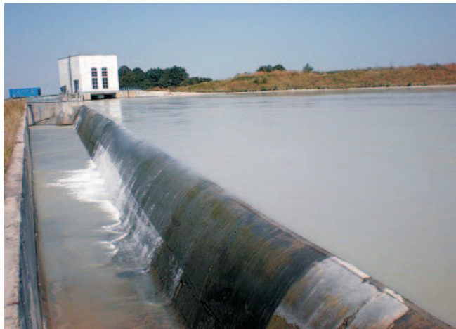
Рис. 7. Напорный бассейн и боковой водослив (фото автора)
