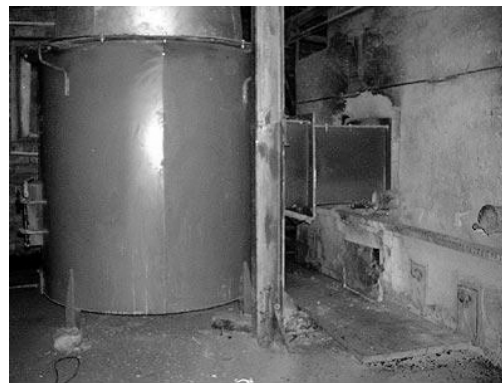
Рис. 3. Реконструированный котельный агрегат с газогенераторной топкой
