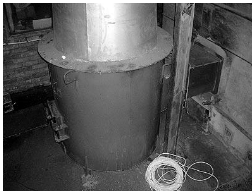
Рис. 3. Реконструированный котельный агрегат с газогенераторной топкой
