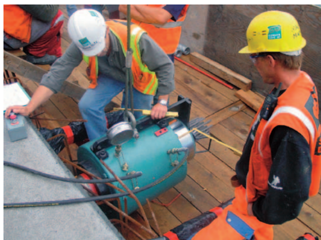
Рис. 6. Натяжение армоканатов горизонтальной арматуры верхней плиты кессона с помощью домкрата
