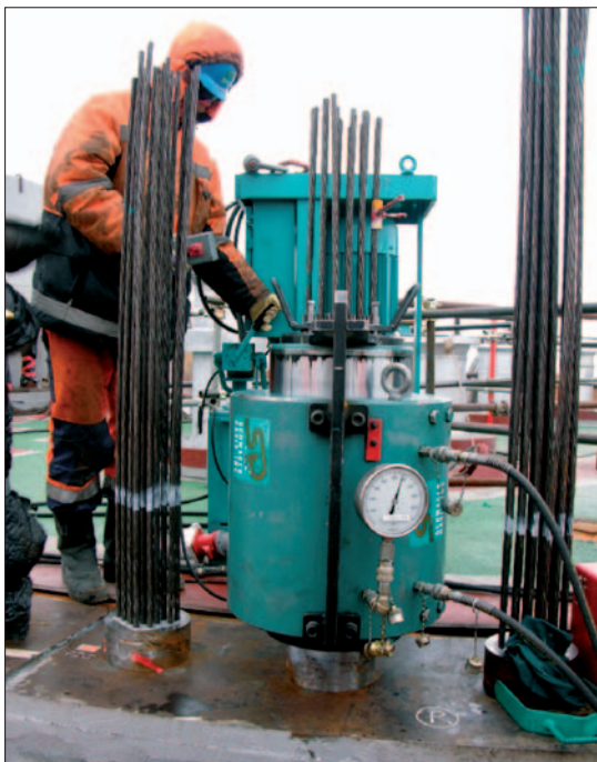
Рис. 9. Натяжение арматуры шахт с помощью гидродомкрата
