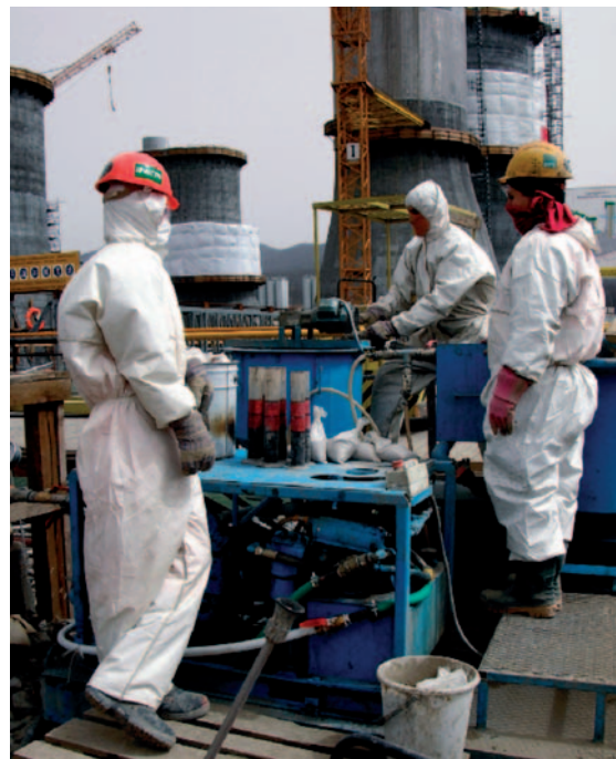
Рис. 10. Подача раствора в каналобразователи шахт
