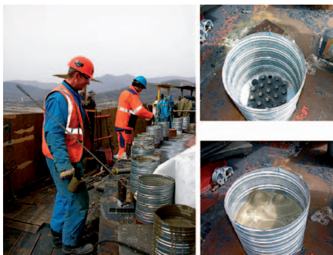
Рис. 11. Цементация вертикальных каналов
