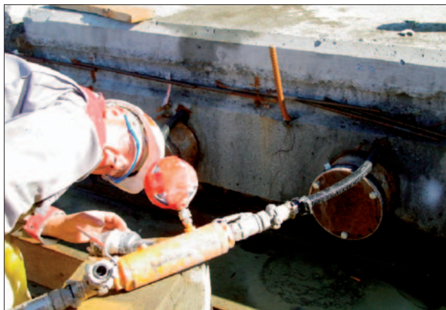
Рис. 7. Цементация натянутых армоканатов верхней плиты кессона
