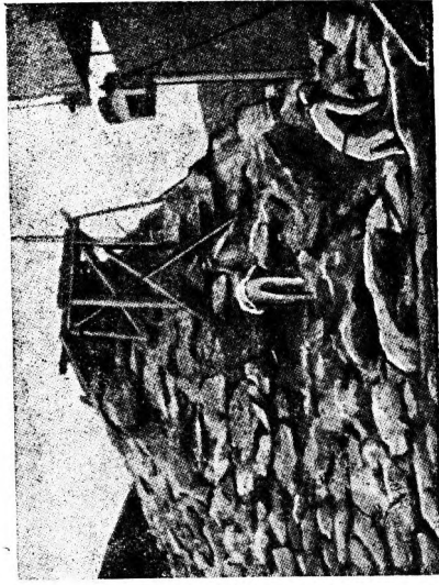
Фиг. 68. Производство сухой кладки плотины Торлебе.
