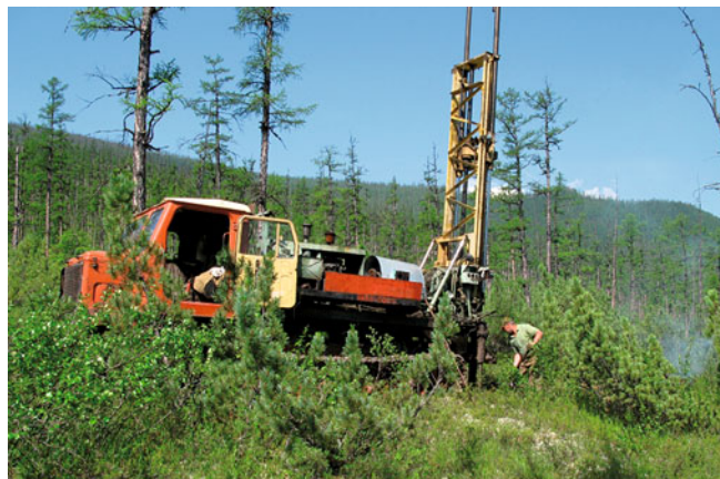
Рис. 2. Буровые работы на участке месторождения № 2 Канкунской ГЭС
