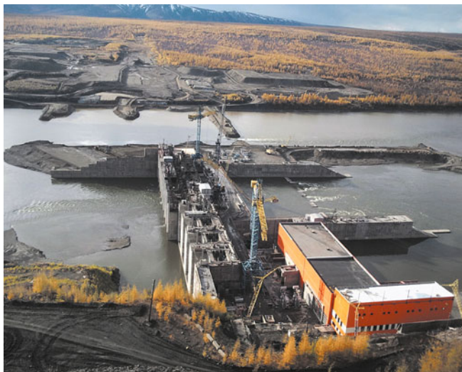
Рис. 1. Строительство Усть-Среднеканской ГЭС на р. Колыме. Перекрытие русла реки (сентябрь 2011 г.)
