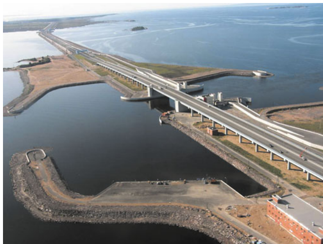
Рис. 4. Судопропускное сооружение С-2 с подъемным мостом
