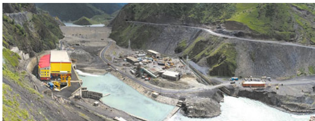
Рис. 2. Вид на сооружения головного узла
