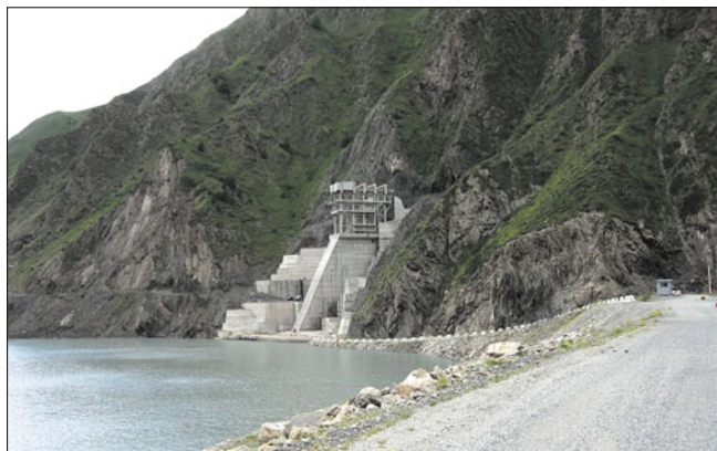
Рис. 4. Строительно-эксплуатационный водосброс головного узла сооружений
