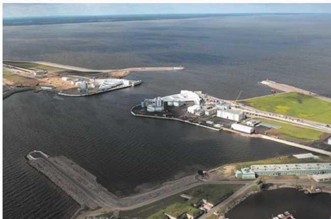
Рис. 3. Судопропускное сооружение С-1
