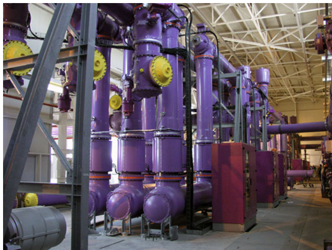
Рис. 1. Бурейская ГЭС. КРУЭ-500 кВ на шесть присоединений
