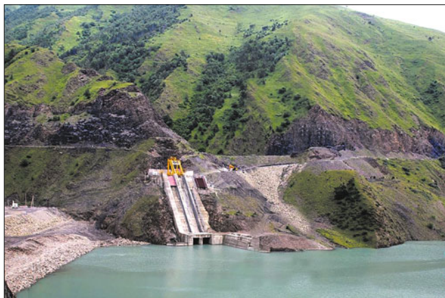
Рис. 3. Водоприемник Головной ГЭС
