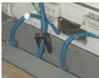
Рис. Б.1 Высокочастотный трансформатор тока «СТ-45» с разомкнутым сердечником.
