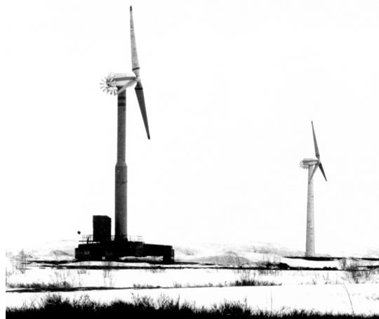
Рис. 8. Первая в мире заполярная ВЭС мощностью 1,5 МВт в Воркуте
