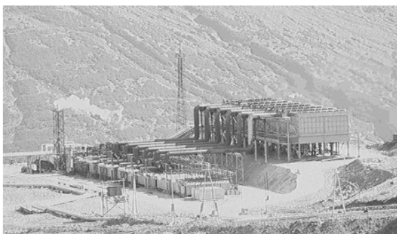
Рис. 10. Экологически чистая Верхне-Мутновская ГеоЭС мощностью 12(4x3) МВт
