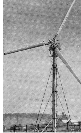
Рис. 7. ВЭУ «Сокол» мощностью 15,2 кВт
