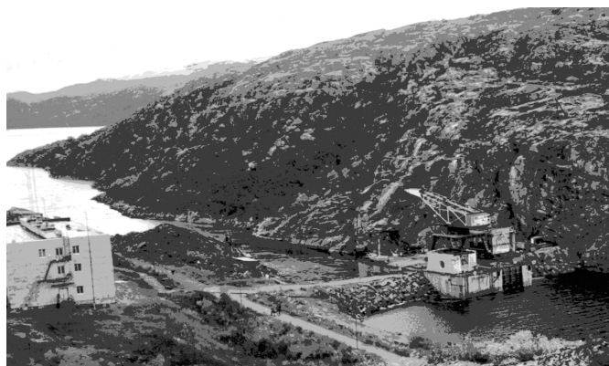
Рис. 3. Общий вид гидроузла Кислогубская ПЭС (лето 2005 г.)
