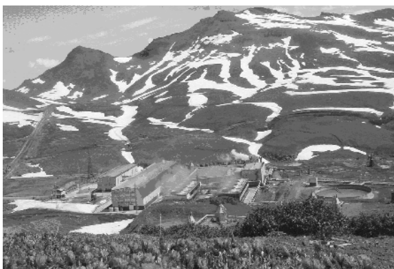
Рис. 11. Первая Мутновская ГеоЭС мощностью 50 МВт
