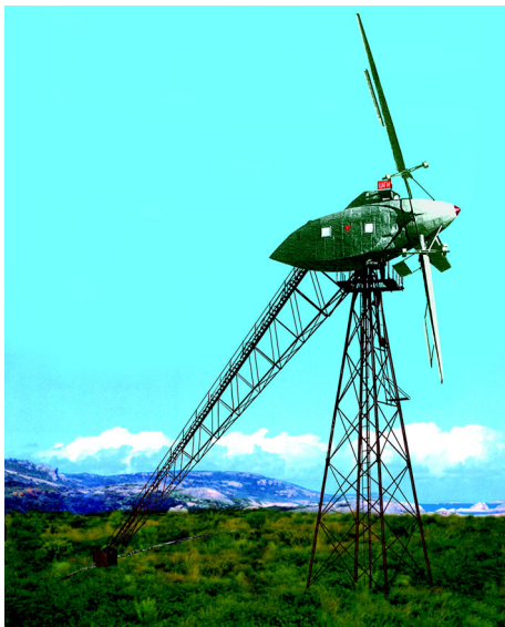
Рис. 2. Балаклавская ВЭС 100 кВт
