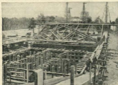
Фиг. 69. Устройство теплицы и установка опусковых колодцев (справа фотографии) и установка стоек круглыми колодцами (справа).
