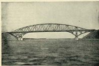
Фиг. 13. Общий вид моста через Клязьминское водохранилище.
