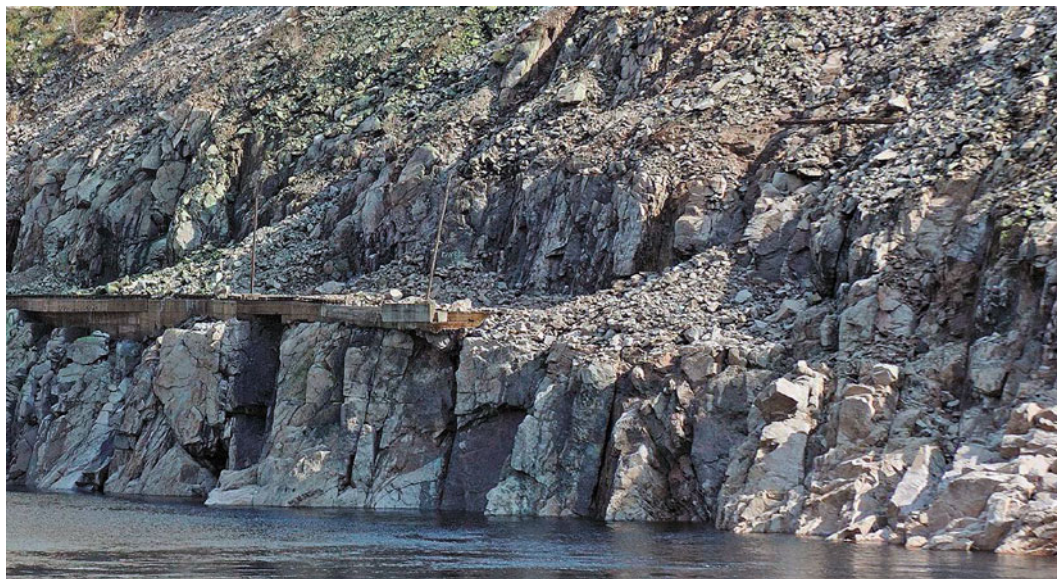
Рис. 1. Состояние левобережного склона после пропуска паводка в 2010 г.
