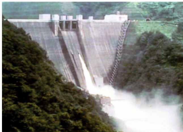
Рис. 6. Наиболее высокая в Японии плотина из укатанного бетона Миягасае, 156 м
