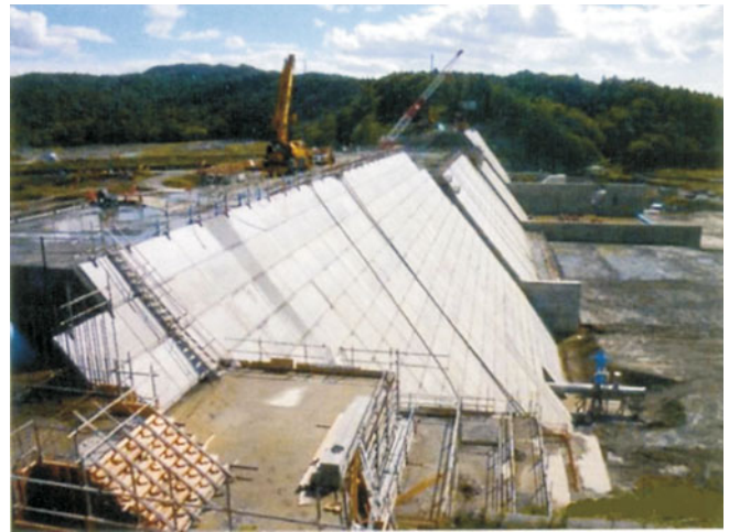
Рис. 8. Общий вид строительства плотины Тобетсу
