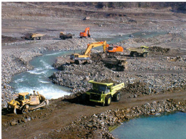
Рис. 14. Разработка и вывоз наносов из водохранилища гидроузла Макио
