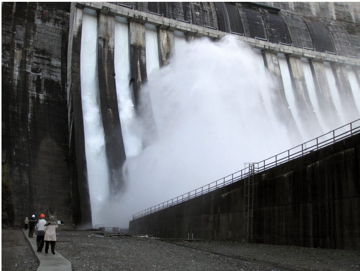
Рис. 2. Вид на водосбросную плотину с правого берега р. Енисей
