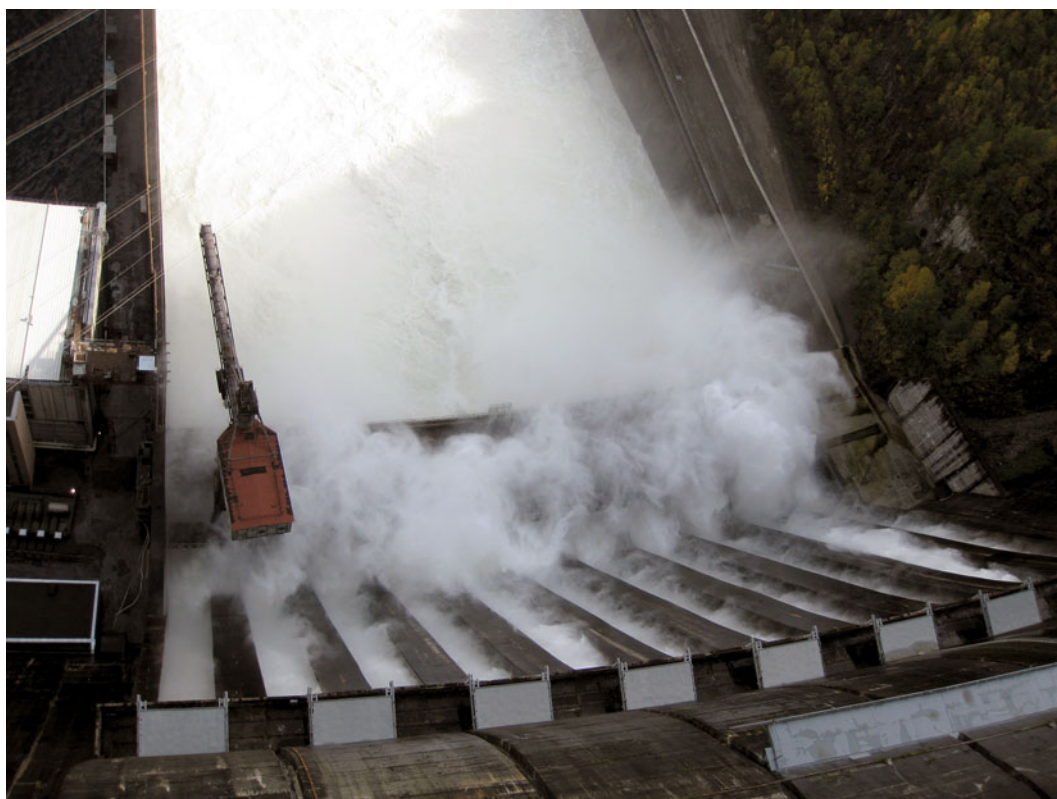
Рис. 1. Вид на сбросные лотки и водобойный колодец с гребня плотины Саяно-Шушенской ГЭС
