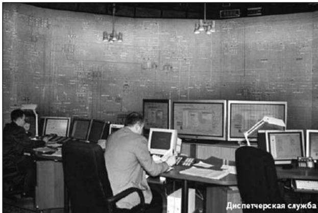
нах которых диспетчеру предоставляется вся необходимая оперативная информация. Наличие в составе АРМов 3 мониторов позволяет диспетчерскому персоналу одновременно отображать на мониторах информацию различных типов: мнемосхемы участков сети и подстанций, различные информационные видеокадры, расчетные схемы сети, архивы и журналы событий.
