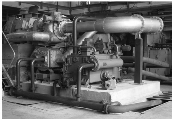
Рис. 3. Турбокомпрессор ТКА 80/9 на заводской компрессорной станции
