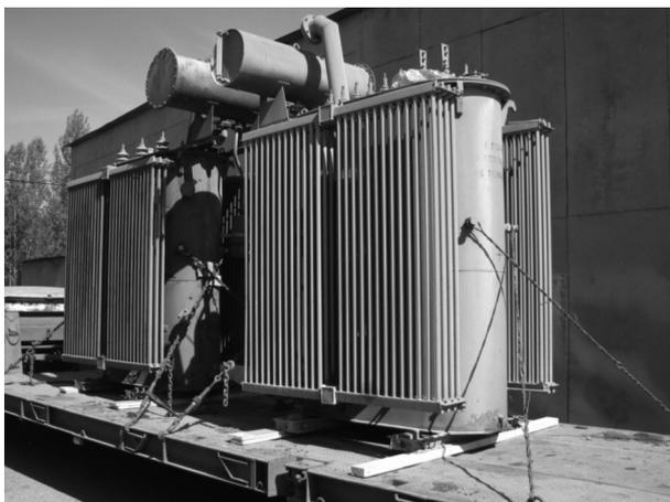
Рис. 1. Трансформатор масляный, высоковольтный, силовой
