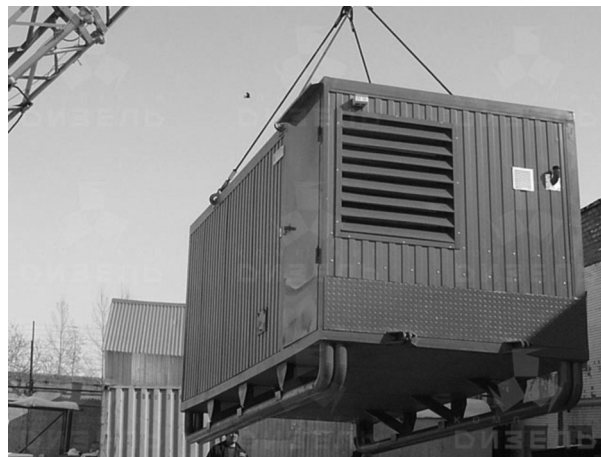
Рис. 2. Дизельная электростанция АД200-Т400-2РК в утепленном контейнере «Север» на салазках
