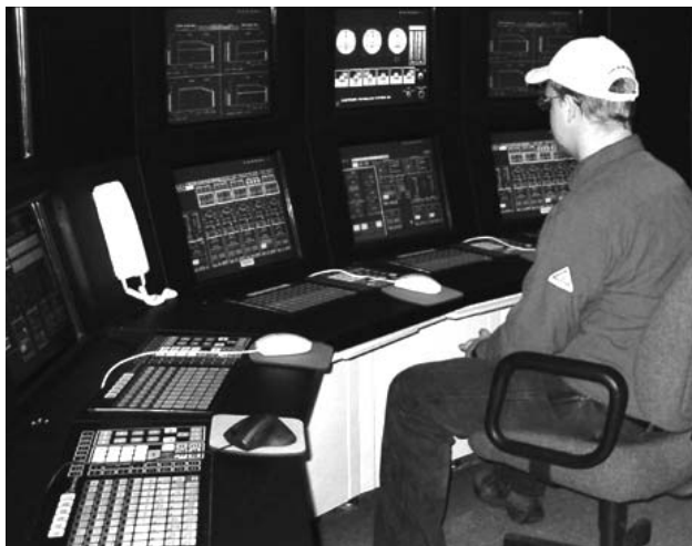
Фото. 4. Тренажер электростанции Roxboro Plant.
