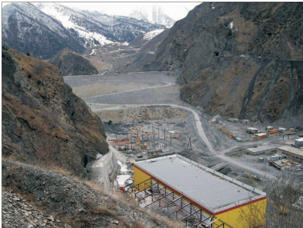
Рис. 6. Зарамагские ГЭС — вид на плотину и здание Головной ГЭС
