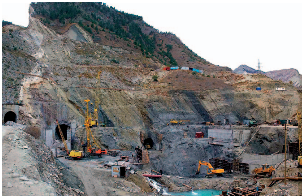
Рис. 4. Строительство Гочатлинской ГЭС — котлован здания ГЭС
