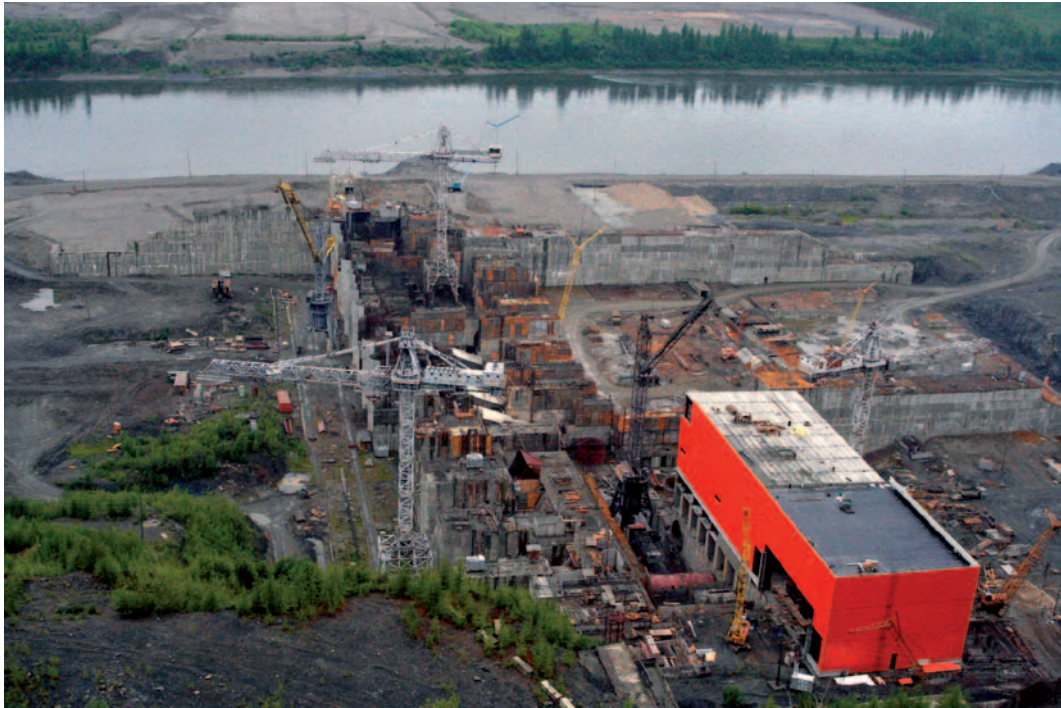
Рис. 7. Строительство Усть-Среднеканской ГЭС
