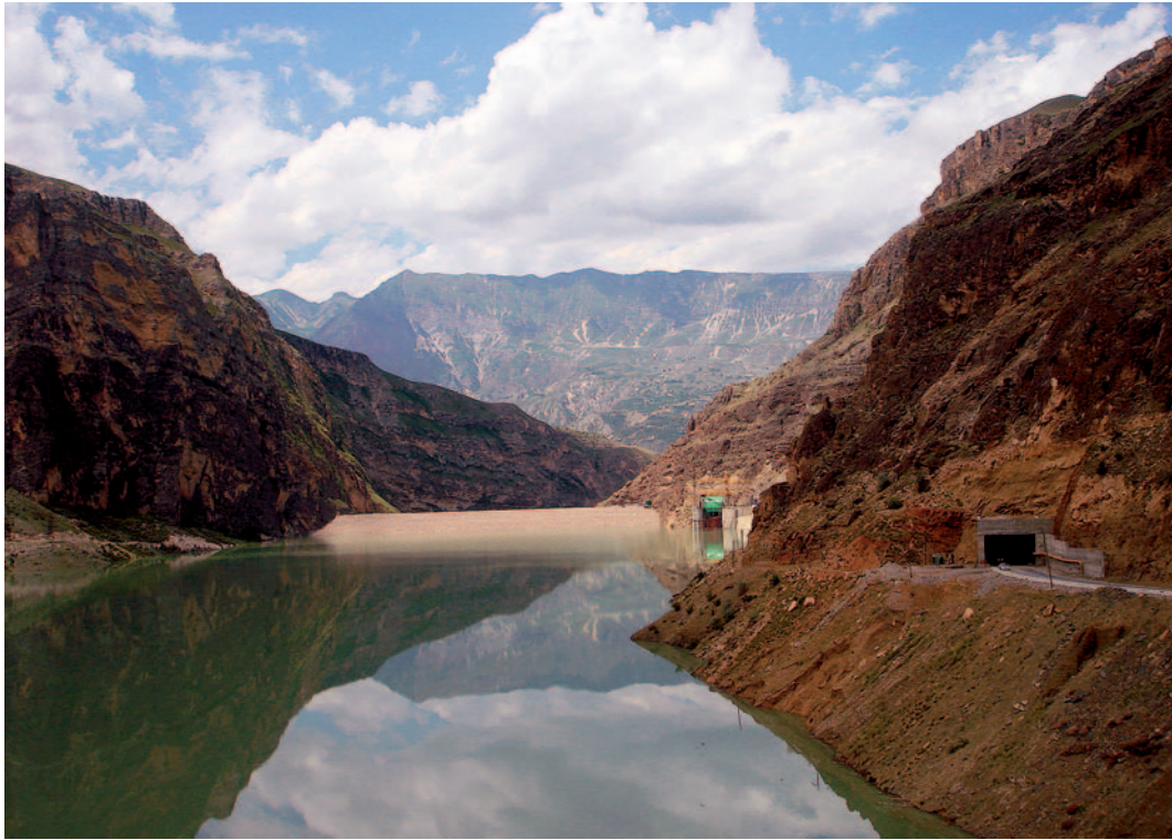
Рис. 3. Ирганайская ГЭС — вид на плотину с верхнего бьефа
