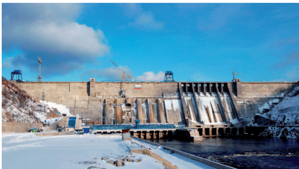
Рис. 2. Бурейская ГЭС — вид с нижнего бьефа
