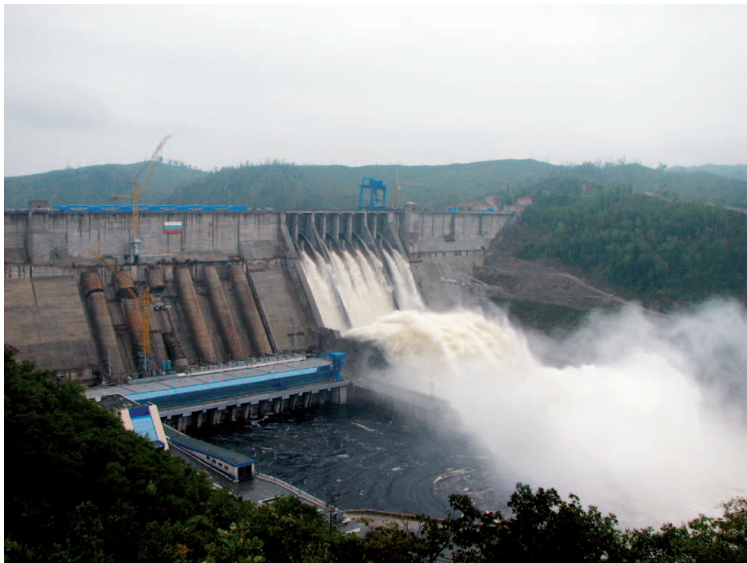
Рис. 1. Бурейская ГЭС — испытания водосброса
