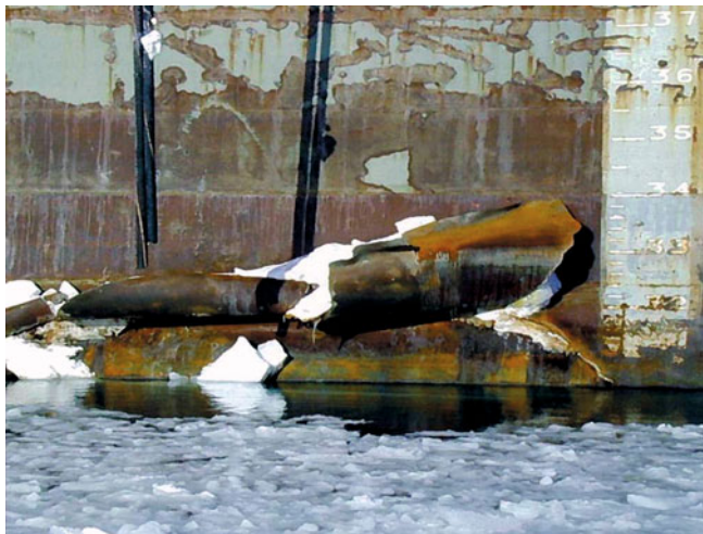
Рис. 2. Разрушение ледового пояса на платформе “Моликпак”
