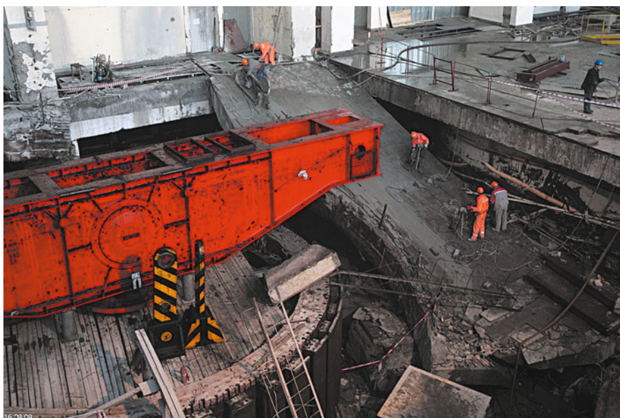
Рис. 2. Канатная резка плиты ГА-2 Саяно-Шушенской ГЭС
