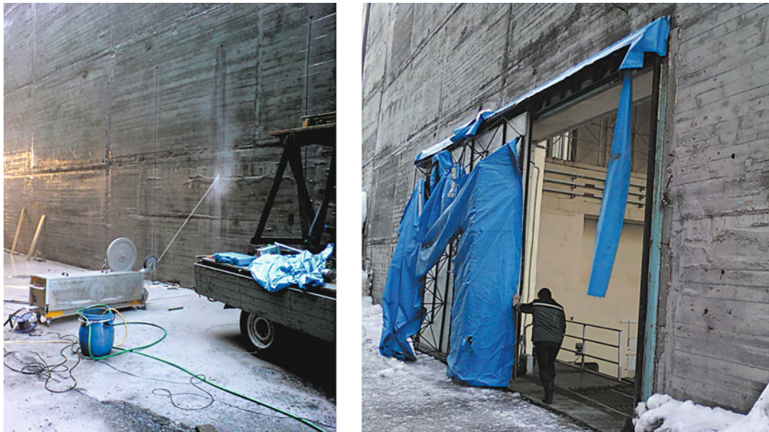
Рис. 1. Вырезка проема в торцевой стене машинного зала (во время работ и после их выполнения)
