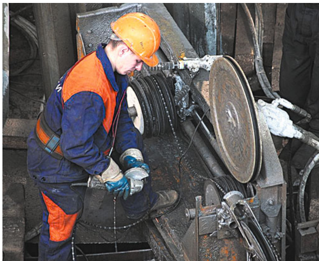
Рис. 3. Алмазная резка вала ротора на ГА-2
