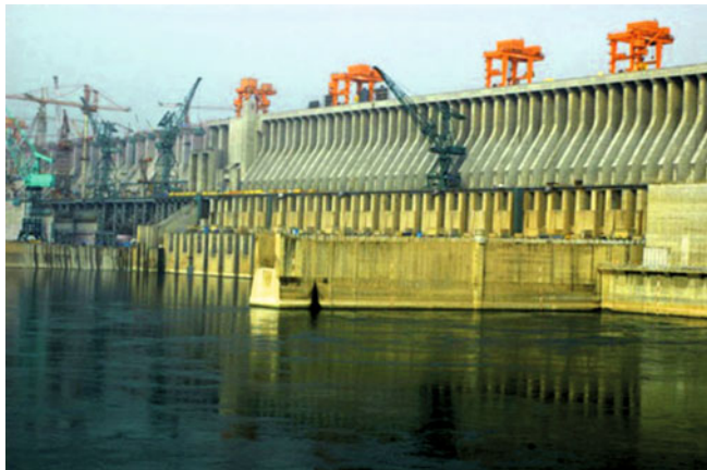
Рис. 3. Водосбросная плотина ГЭС “Три ущелья”
