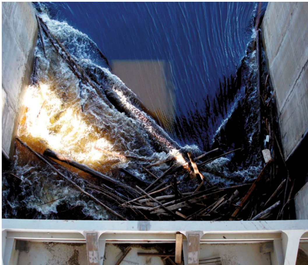
Рис. 3. Истечение из-под затвора при открытии на 5,6 м, УВБ = 253 м
