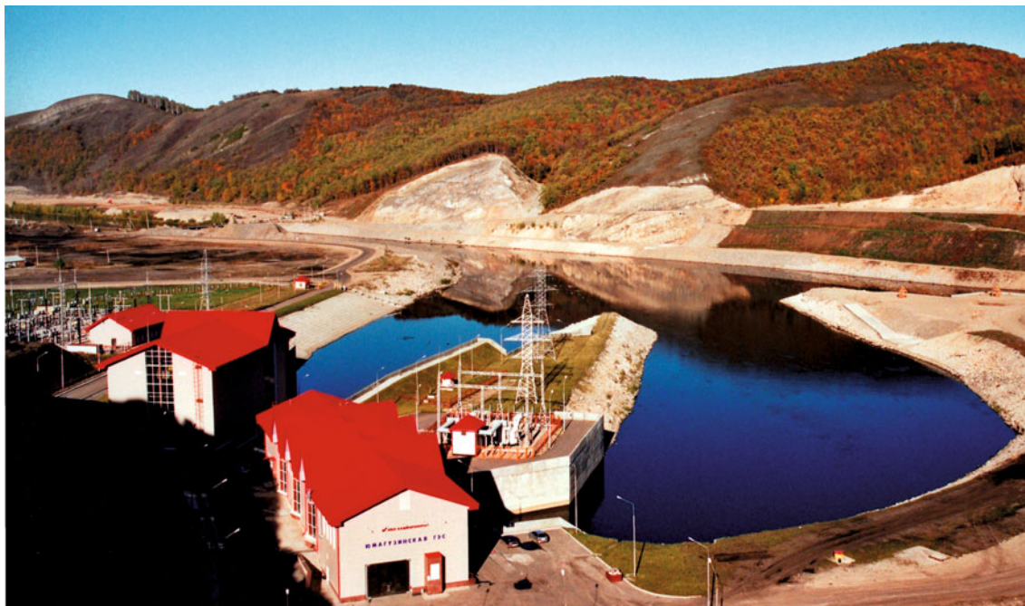
Рис. 6. Здание ГЭС (вид с плотины в сторону нижнего бьефа). Слева — выходной оголовок донного водосброса
