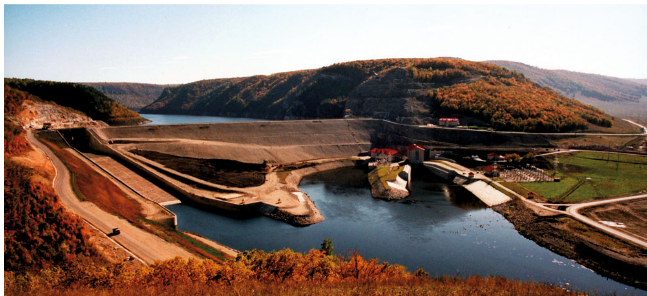
Рис. 1. Панорама Юмагузинского гидроузла со стороны нижнего бьефа
