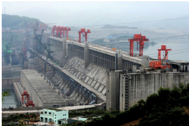
Рис. 2. Левобережное машинное здание ГЭС “Три ущелья”
